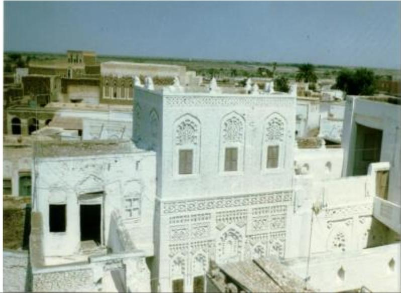
الشكل رقم ( 2-2 ) كيفية الاستفادة من بروز الأدوار العليا واختلاف مناسيب الأسطح لتضليل مساحة الأسطح للمباني.
