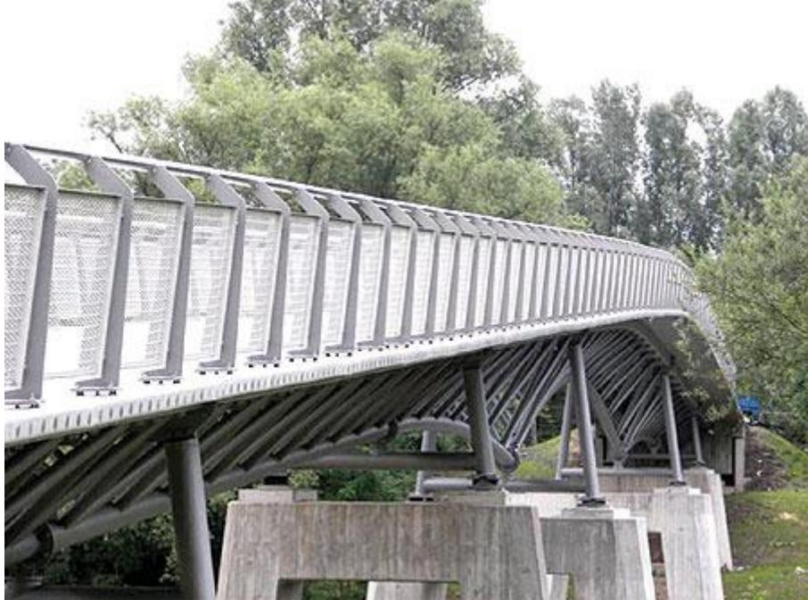
شكل رقم ٣-١٠ يوضح جسر حديقة الكاسل الذي بني بالإسمنت الفائق الكفاءة (UHPC)
