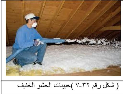
وتتكون هذه المادة العازلة من حبيبات صغيرة ، وعند استخدام عزل الحبيبات فإن معدات الشفط الموجودة في الناقلات الحاملة لهذه المادة العازلة تقوم بشفط الحبيبات وتوجيهها للمكان المطلوب عزله: ( شكل رقم ٣٢ - ٧ )
