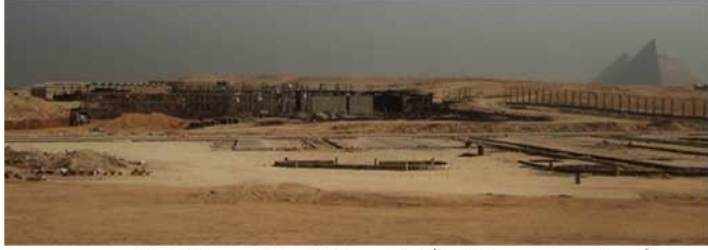
مراحل بناء مبنى مركز الزوار 02 - 09 - 2010
