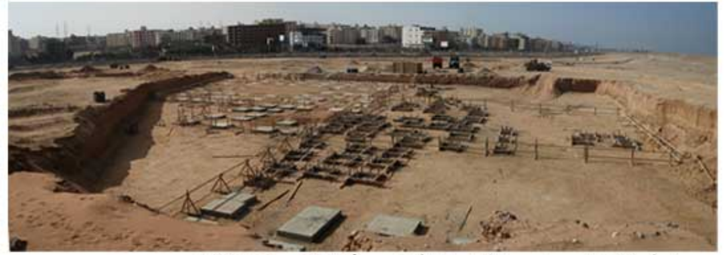
مراحل تنفيذ مبنى الادارة الهندسية 04 - 2009
