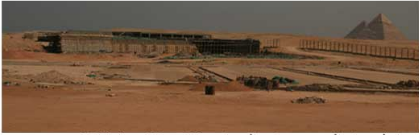
مراحل بناء المبنى مركز الزوار 28 - 03 - 2011
