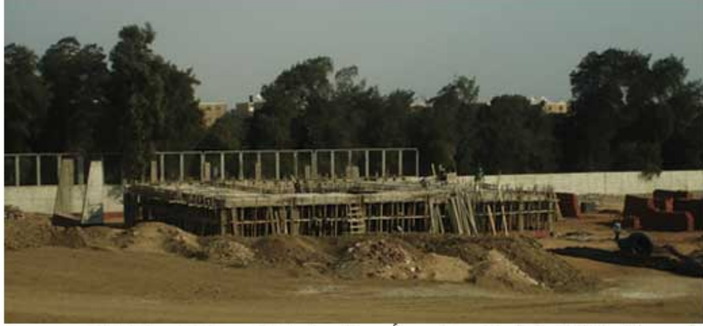
المرحلة التنفيذية لمبنى نادي أبو الهول 28 - 03 - 2011
