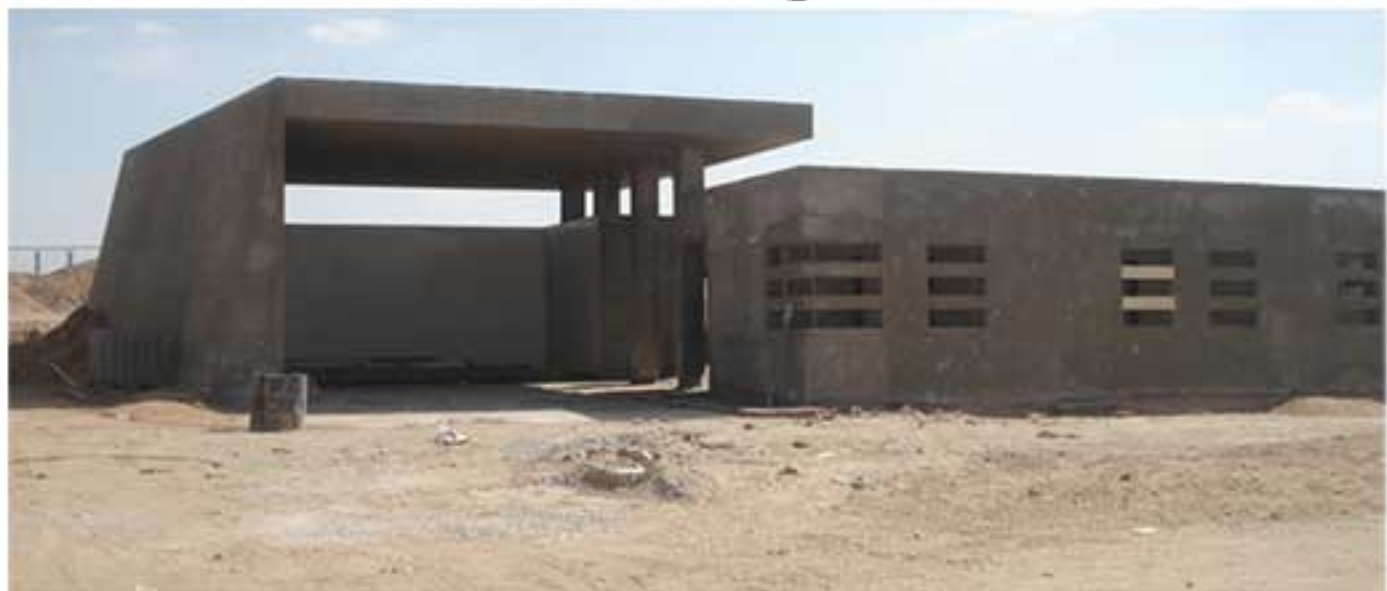
المرحلة التنفيذية لمبنى الدفاع المدني 02 - 09 - 2010
