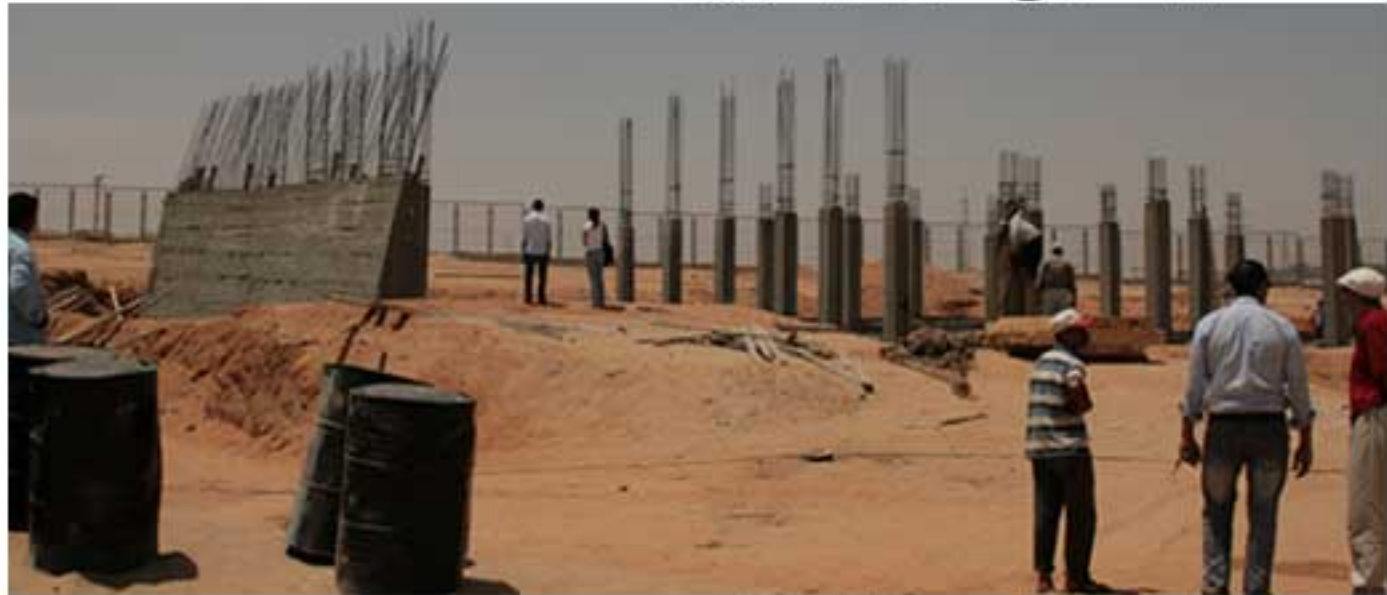
المرحلة التنفيذية لمبنى الدفاع المدني 20 - 06 - 2009
