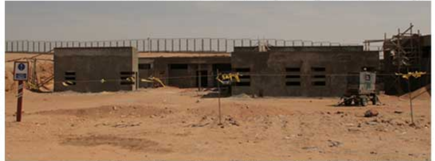
مراحل تنفيذ مبنى الادارة الهندسية 19 - 05 - 2010
