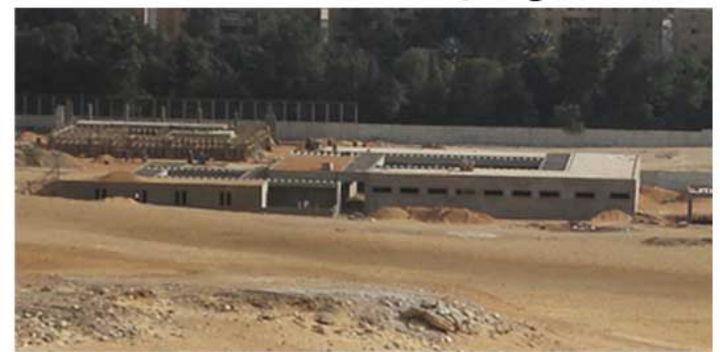
المرحلة التنفيذية لمبنى الهجانة 15 - 12 - 2010
