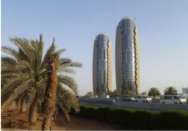
الشكل (3-3) أبراج البحر في أبو ظبي تحتوي على واجهة متحركة بتصميم المشربية يتم التحكم بها تبعاً لاتجاه الشمس لخفض الحرارة داخلها وتقليل استهلاك الطاقة، أختارها مجلس المباني الشاهقة والمسكن الحضريّة الكائن في ولاية شيكاغو الأمريكية لجائزة "المبنى المبتكر" لعام 2012. [iii]
