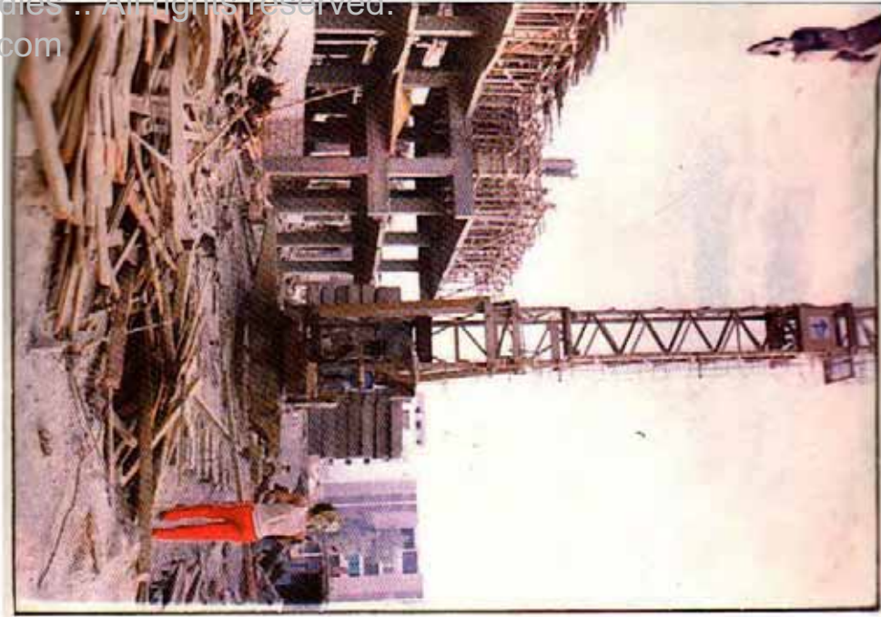
شكل (١٨٧) وضع ثقل مناسب على قاعدة الرنش المتحرك على قضبان لضمان اتزانه
