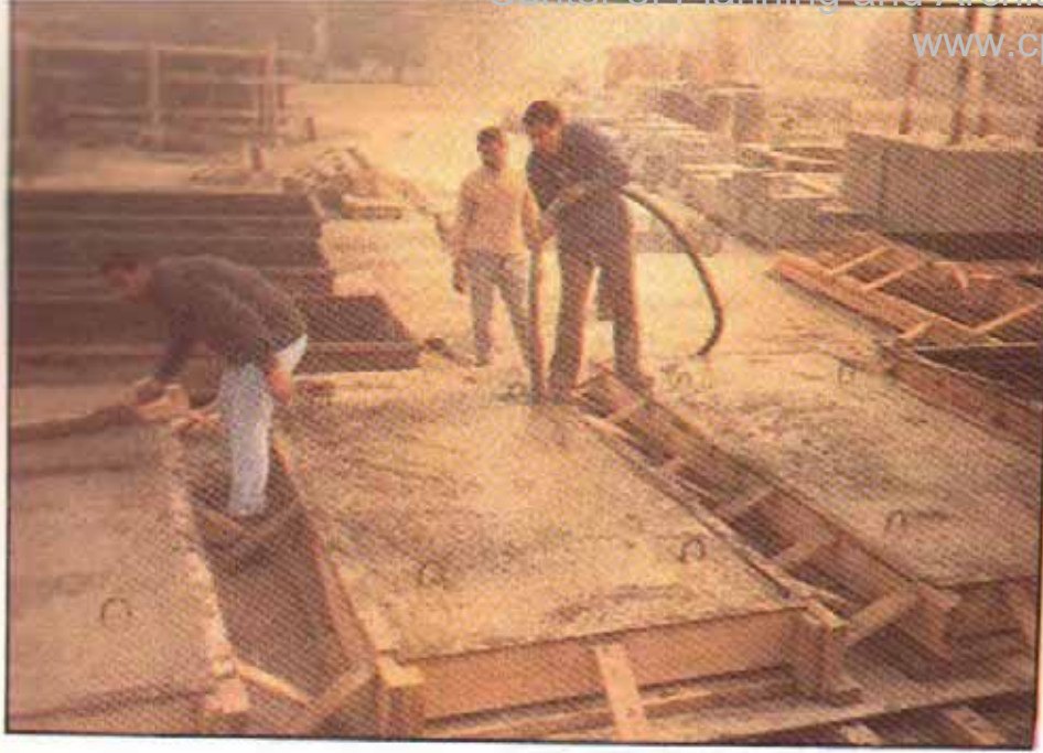
شكل (١٧٧) دماك الخرسانة بالهزاز
