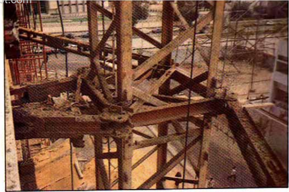
شكل (١٩٦) تثبيت الونش بالمشدات إلى المبنى من الخارج
