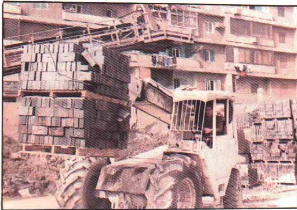
شكل (١٦٦) اللودر الشوكية يحمل الطوب الأزرق
