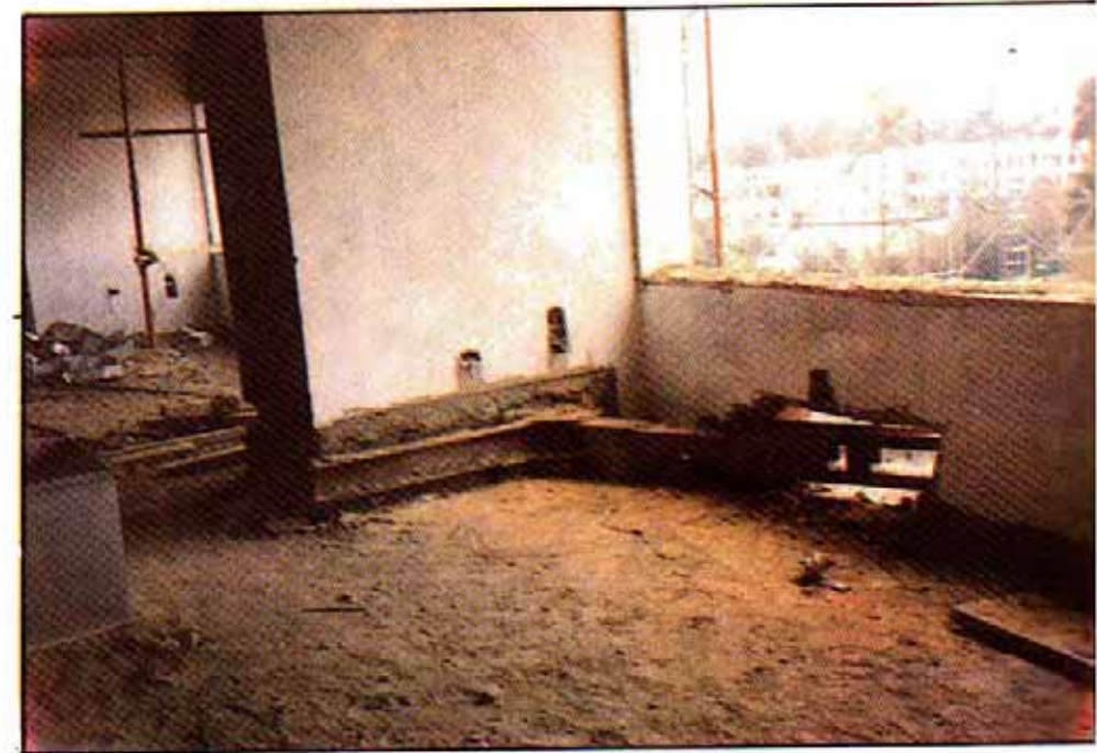
شكل (١٩٧) التثبيت الداخلي في الأعمدة
