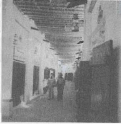
ج- ممر مغطى بسوق العرصة بعد الترميم
