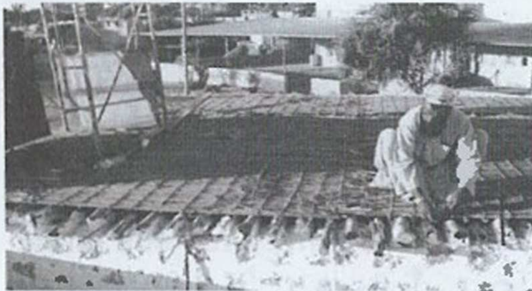
هـ - عملية إعادة تركيب السقف التقليدي
