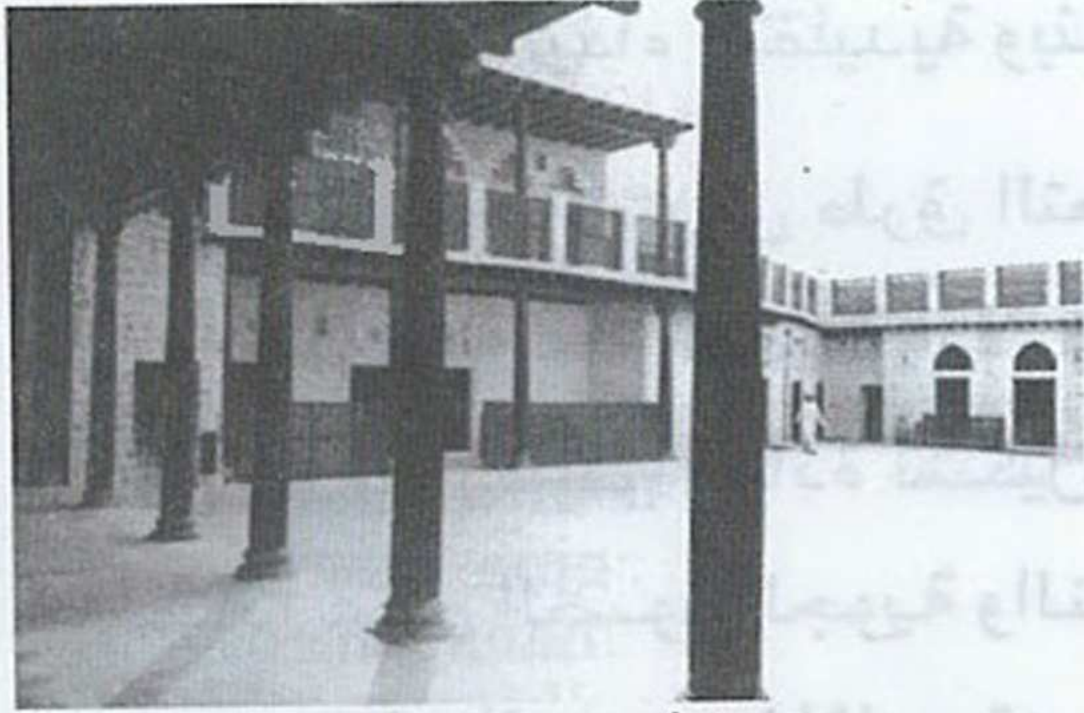
بيت النابودة قبل أعمال الترميم
