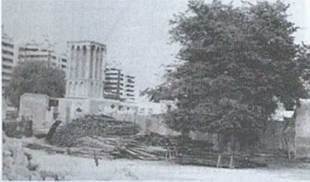
ج- تحضير مواد البناء اللازمة
