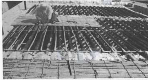
د- وضع السقف الجديد للفراغات الداخلية بالحصن
