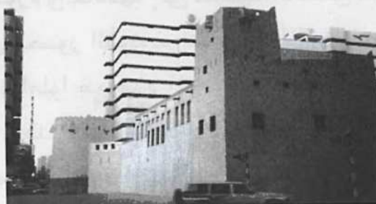
د- صورة جانبية للمبنى توضح تجانس مواد البناء وإزالة كل الإضافات
