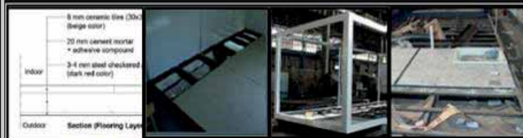
المراحل المختلفة لتثبيت الطبقات على صفائح فولاذية ذو عوارض الأرضية بالمناطق الرطبة
