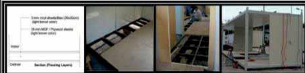
المراحل المختلفة لتثبيت الألواح الخشبية على عوارض الأرضية في الفراغات الحية
