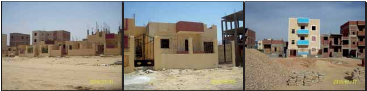
شكل (٢- ٣٩) مباني مهجورة بدون {مياه/ كهرباء/ صرف/ غاز} نظراً لتأخر دخول المرافق (بواسطة الباحثين، ٢٠١٣م)
