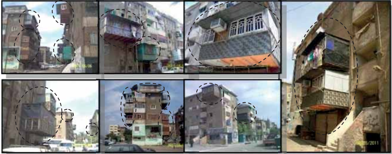
شكل (٤- ٢٦) ظهور بعض الحلول بواسطة السكان وذلك من خلال تزويد بعض الغرف السكنية بأحدي جوانب المبني بوحدات صندوقية تتكون من كابولي من الحديد وحوائط من الخشب والألومنيوم وسقف من الصاج المعرج (تصوير بواسطة الباحث، ٢٠١١)
