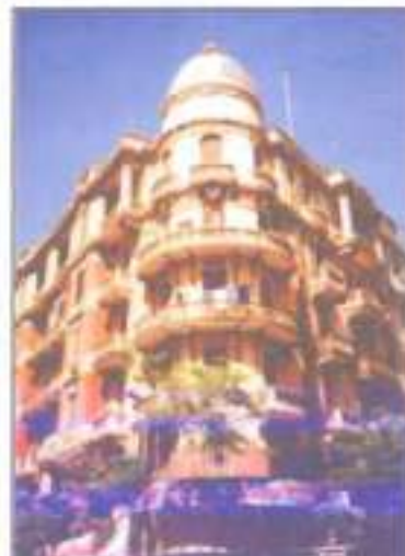
عمارة سكنية - ١ ش محمد مظلوم باشا، تاريخ الإنشاء: حوالي ١٩٢٨م، الطراز: نيل باروك وآرت ديكو مع تأثير عمارة حوض البحر المتوسط (عن: د. سهير زكي حواس، ٢٠٠٢م، ص ٤٣)
