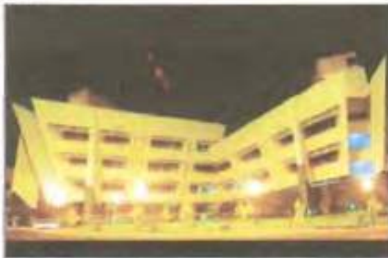
شكل (٢-٣): تأثر العمارة المصرية بالنموذج الغربي. مبنى مباحث أمن التولة، مشيئة نصر، القاهرة.
