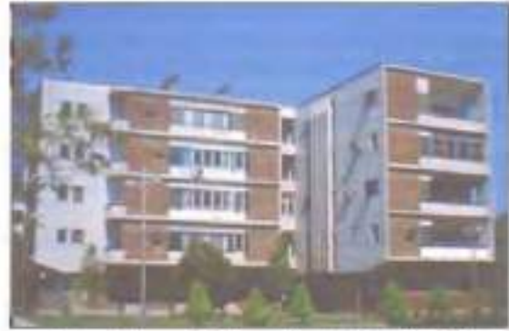
شكل (١٦-١): مبنى جامعة أسيوط، أسيوط. ( عن: www.archnet.org , accessed October 2007 )
