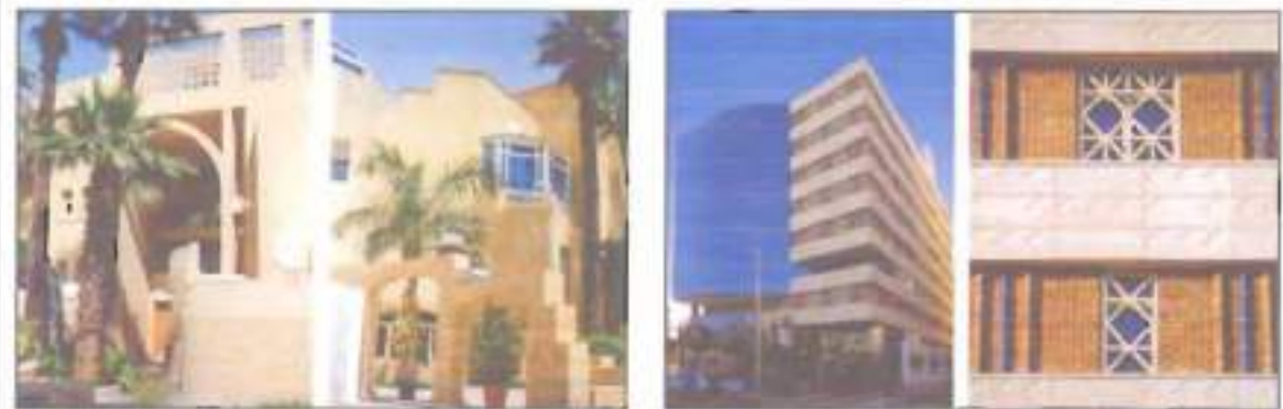
شكل (١٣-١): مبنى سيداري، مصر الجديدة، القاهرة. شكل (١٤-١): بقاعة النيل للفنون، الزمالك، الجيزة. ( عن: مجلة البناء، العدد: ١٦٨، أبريل ٢٠٠١م، من ٥٧/٥٥ ) ( المصدر: الباحث )
