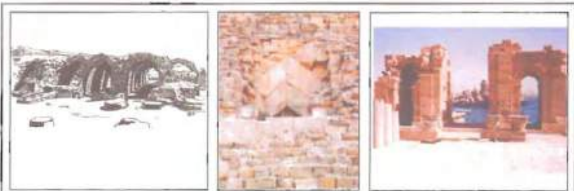
عقد نصف دائرية مشيدة بالحجر معبد فيلة - أسوان ( المصدر: الباحث ) عقد ( بسيط ) من كتلتين حجريتين مائلتين - هرم خوفو - الجيزة ( المصدر: الباحث ) عقد نصف دائرية مشيدة بالطين طبة ( عن د. سيد كريم، ١٩٩٦م، ص ٣٢٨ )
