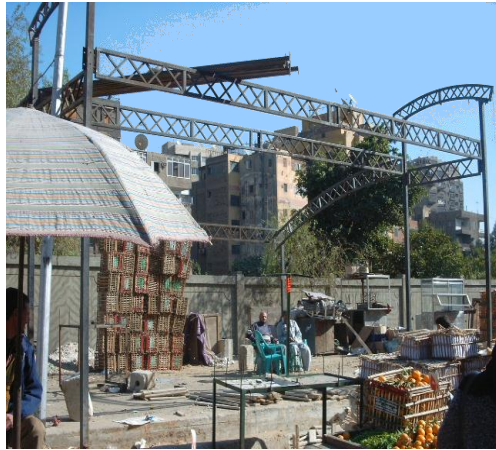
شكل (٥٨-٧) السوق أثناء أعمال التنفيذ، المصدر: GTZ
