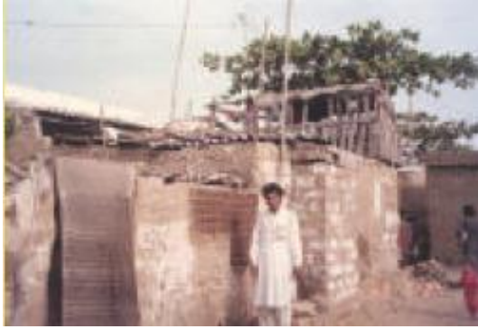
شكل (١-٢١) البحث عن سبب تدنى مستوى المباني التى يبنيتها الفقراء، المصدر: www.oppinstitutions.org
