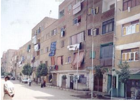
شكل (٥) المباني من الطوب والخرسانة فى المناطق اللارسمية على الأراضى الزراعية. المصدر: GTZ
