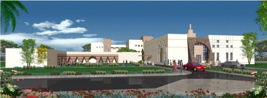
شكل (103) المنظر العام للمدرسة من الواجهة الرئيسية (الجنوبية)
