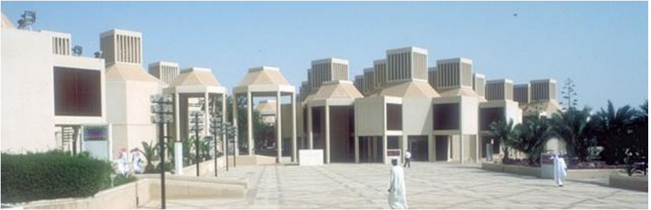
شكل (70) صورة في الأفنية الداخلية المغطاة توضح الإضاءة العلوية و أخرى خارجية للواجهات توضح أبراج التهوية
