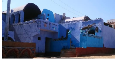
صورة رقم (٦-٣٥) المنازل النوبية التقليدية في غرب سهيل، المصدر: الباحثة
