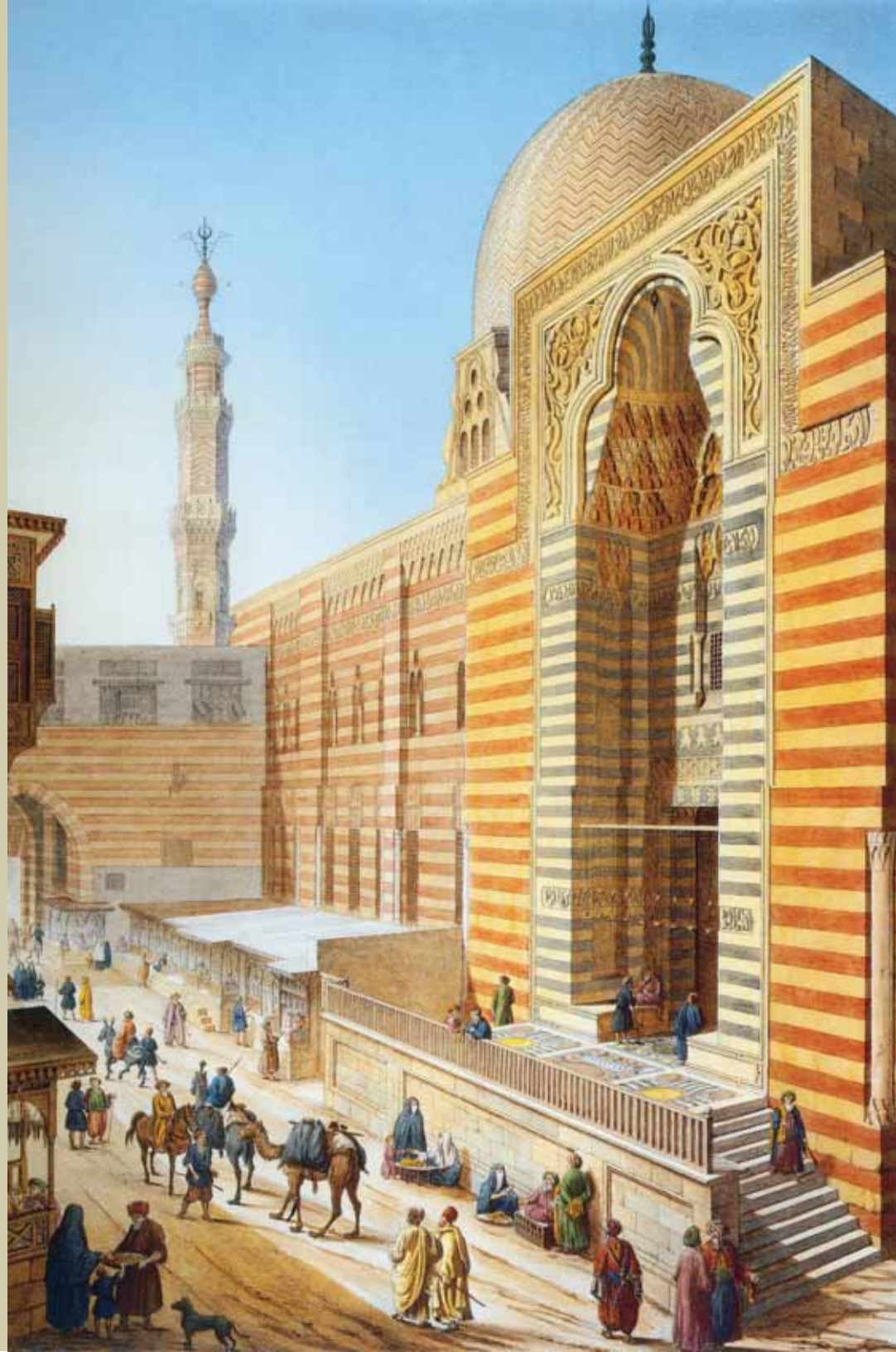
المدخل الرئيسي لجامع المؤيد شيخ
