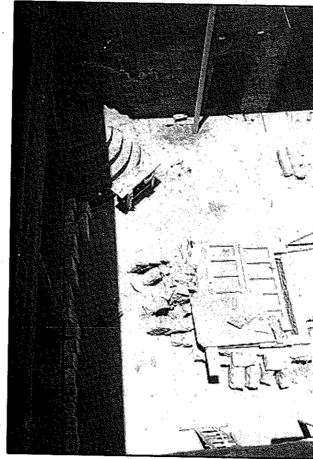
صورة رقم (١٦) : ( فناء منزل السنارى ) الأجزاء المعرضة للشمس من أرضية الفناء (الساعة ١٢ ظهراً يوم ٢١ يونية) ، ويلاحظ كمية الظلال الصغيرة على أرضية الفناء والموازية تماماً للواجهة البحرية وذلك لأن الفناء يواجه الشمال الجغرافى .
