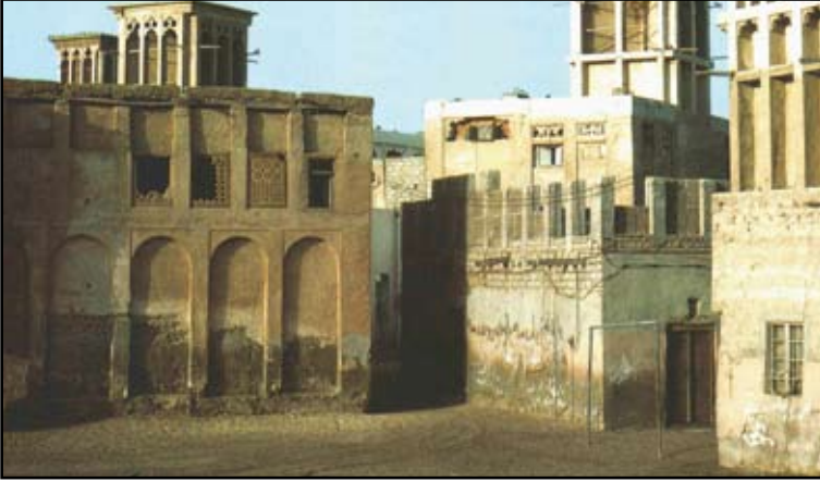
شكل (٢١): نماذج من أبراج الرياح ببيوت حى البستكية القديم بدبي التي كانت تستخدم في التهوية، والتي يمكن الاستعانة بها في تصميم المباني المعاصرة بعد تطويرها.
