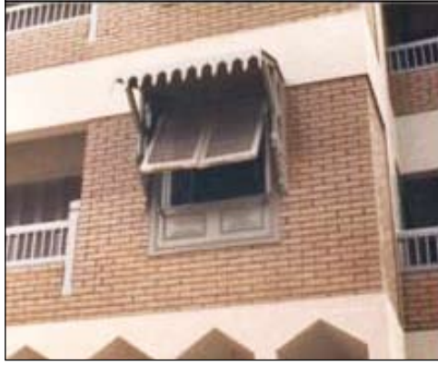
نموذج معاصر لتصميم الشباك الشيش بنفس طريقة المشربية التقليدية. (من تصميم المؤلف)
