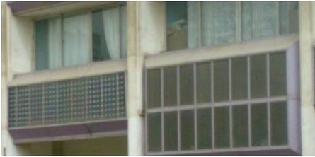
شكل ٣٢ استخدام الخلايا الكهروضوئية أحادية البلورة باللون الأسود، ومتعددة البلورة باللون الأزرق.
