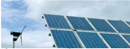
شكل ٤-١٩ النظم المدمجة بين الخلايا الكهروضوئية وتربينات الرياح المصدر: www.ruralelec.org .
