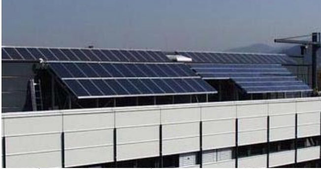
شكل ٢١-٧ استخدام الخلايا السلكونية متعددة البلورة المصمتة بالون الأزرق في الوحدات المائلة المثبتة علي السطح. المصدر السابق.
