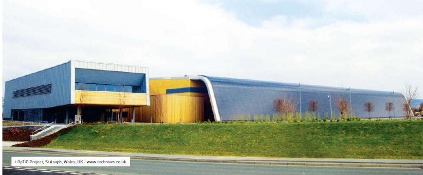
شكل ٥-٦ التشكيل المنحني بمركز OPTIC، شمال ويلز-المملكة المتحدة، ٢٠٠٤م. المصدر www.technium.co.uk
