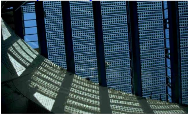
شكل ٧-١٩ استخدام الخلايا السيليكونية متعددة البلورة النصف شفافة في تغطية الاسقف المسننة. المصدر: www.ise.fhg.de
