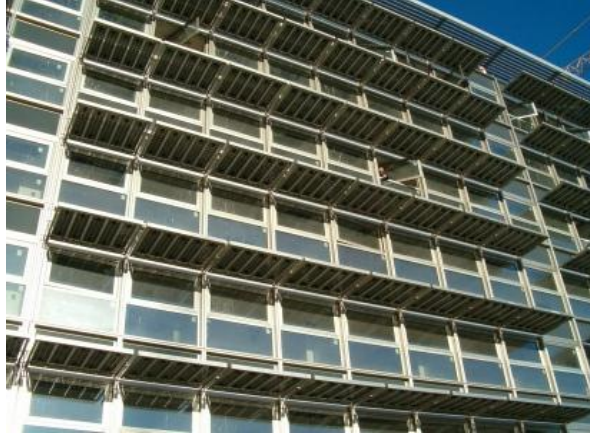
شكل ٦-٣ التشكيل المستقيم للخلايا الكهروضوئية بمبنى فندق مونتي ملجة- أسبانيا . المصدر:
