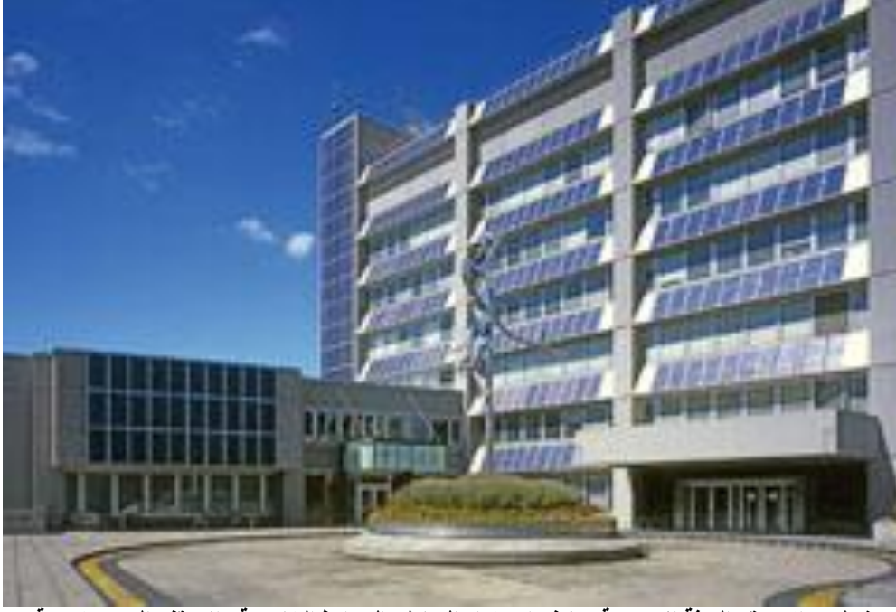
شكل ٥-٢٤ مقر البعثة الأمريكية بجنيف استخدام التكامل بالحوائط الخارجية والأسقف الكهروضوئية. المصدر: www.state.gov
