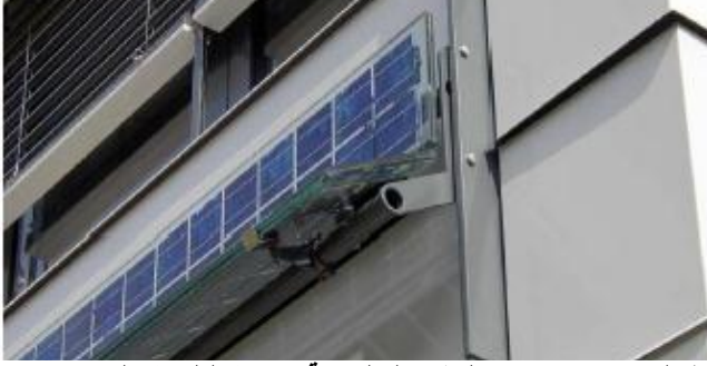
شكل ٢٠-٧ استخدام الخلايا السلكونية متعددة البلورة بالون الأزرق في الكاسرات الشمسية الكهروضوئية. المصدر: www.ise.fhg.de
