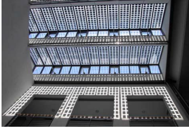
شكل ٢٢-٧ استخدام الخلايا السلكونية متعددة البلورة النصف شفافة في تغطية الكور الداخلي . المصدر السابق.
