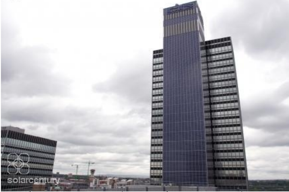
شكل ٦-١٦ اتخاذ ابعاد الخلايا الكهروضوئية كوحدة اساس في تشكيل برج مانشستير- المملكة المتحدة.
