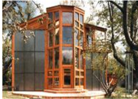
شكل ٣-٥ الأسلوب المختلط استخدام الأسلوب المنفصل (٢) بين حائطين ترومب بالإضافة الي مراوح داخلية. المصدر: www.dennishollowayarchitect.com
