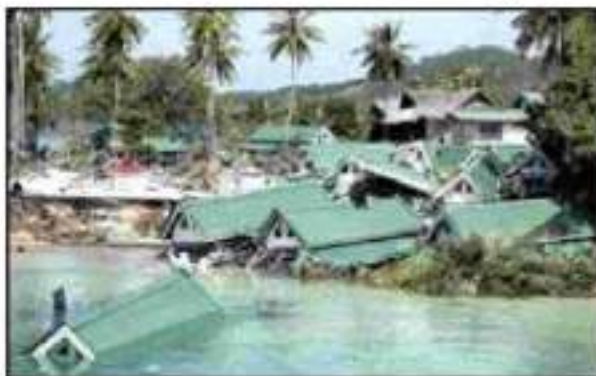
صورة رقم (21/2) توضح جزء من الدمار لكارثة أمواج مد تسونامي -كوارث طبيعية، (المصدر: http://www.q82.net (Accessed 6/4/2006)
