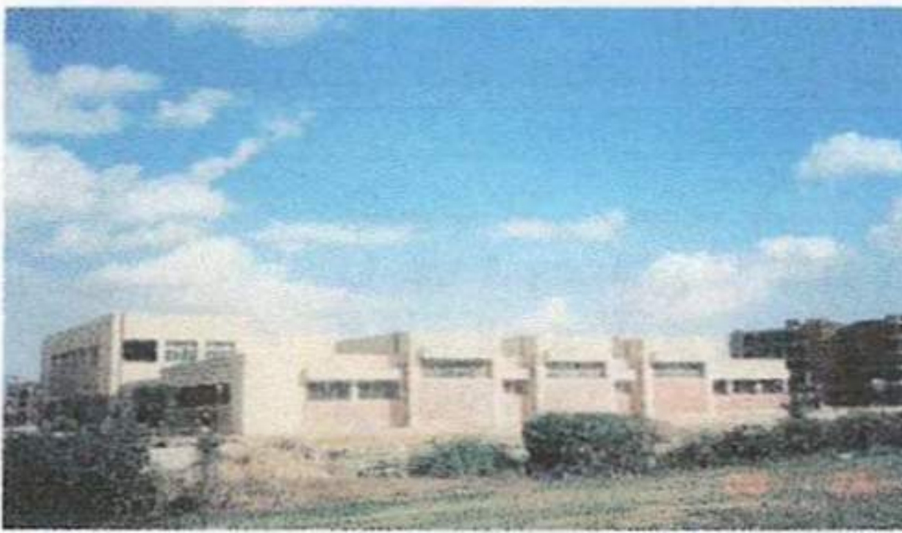
شكل ( ٧-٢-٢ ) استخدام المواد في المنشآت المؤقتة للمشروع
