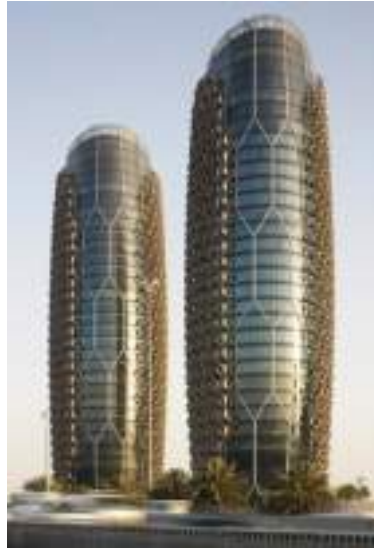
شكل (٣-٢٧) الواجهات الخارجية لأبراج البحر ٣١٧ .
