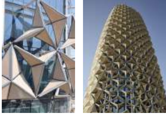
شكل (٣-٢٨) الوحدات المكونة لغللاف الأبراج الخارجي "المشربية" ٣١٨ .
