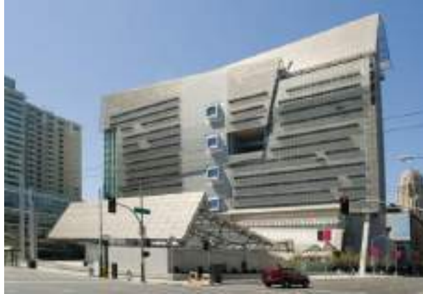
شكل (٣-٤١) الواجهة الجنوبية للمبنى الفيدرالى بسان فرانسيسكو ٣٤١ .
