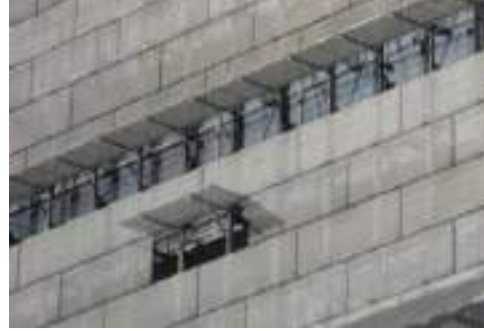
شكل (٤٢-٣) الغلاف المعدني ونظام النوافذ الآلية والفتح والغلق لمبنى San Francisco Federal Building ٣٤٢ .
