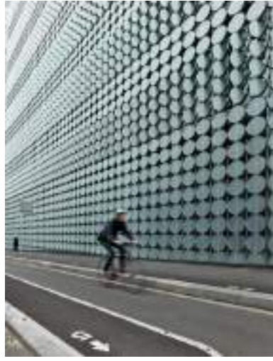
شكل (٢-٢١) الحركة الديناميكية لواجهة مبنى Design Hub (المعهد الملكى للتكنولوجيا بميلبورن (RMIT) إستجابة لحركة الشمس ٢١٨ .
