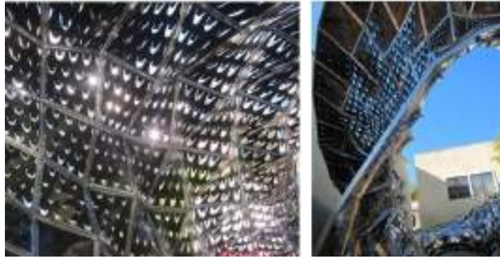
شكل (٣-٣٦) حركة الوحدات المعدنية إستجابة لحركة الشمس ٣٣٢ .
