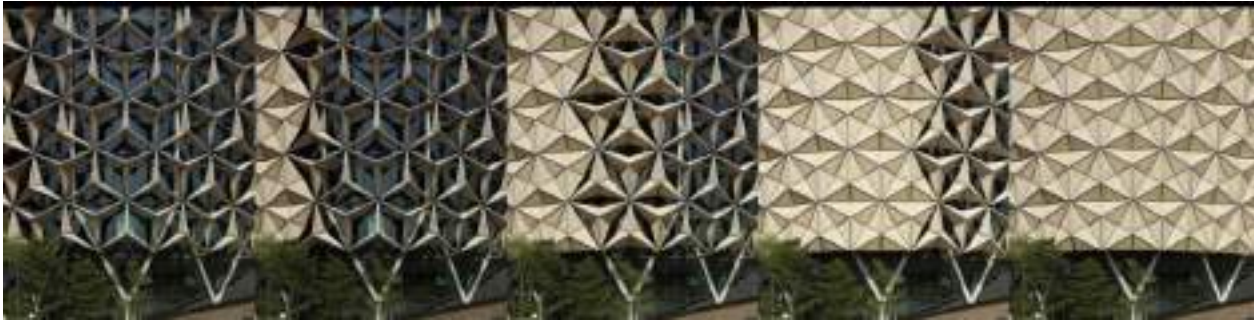
شكل (٣-٢٩) وضعيات الفتح والغلق بالغللاف الخارجي للأبراج إستجابة لحركة الشمس ٣٢٠ .
