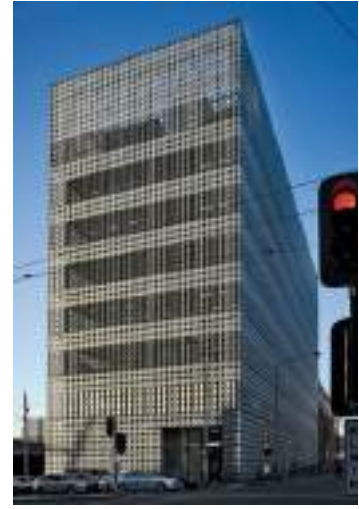
شكل (٢-٢١) الحركة الديناميكية لواجهة مبنى Design Hub (المعهد الملكى للتكنولوجيا بميلبورن (RMIT) إستجابة لحركة الشمس ٢١٨ .
