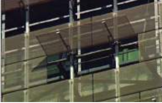
شكل (٤٢-٣) الغلاف المعدني ونظام النوافذ الآلية والفتح والغلق لمبنى San Francisco Federal Building ٣٤٢ .
