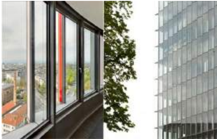
شكل (١٥-٣) نظام النوافذ الآلية الحركة بمبنى " KfW Headquarters " ، يمين الواجهة الخارجية للنوافذ ، يسار النوافذ الداخلية بالأدوار ٢٩٤ .
