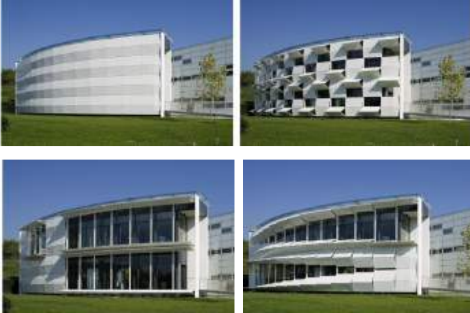
شكل (١٧-٢) واجهة مبنى شركة Kiefer technic بأستراليا ، والوضعية المختلفة للواجهة أثناء الحركة ٢٠٩ .
