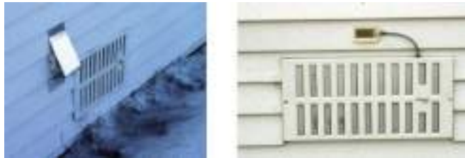
شكل (٢-١٦) أماكن أجهزة الإستشعار " sensors " خارج المبنى ٢٠٠ .
