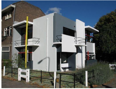
اللوحة ١٣ G.Rietveld and T. Schroder: Schroder House at Utrecht. ١٩٢٤- عوارض خرسانية وطوب وجص وخشب وعوارض فولاذية - أوترخت ، هولندا
