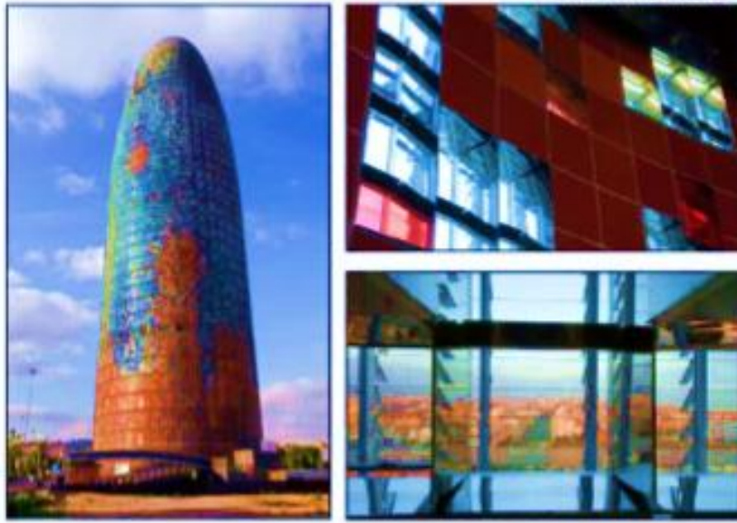
شكل (٢٤-٢) استخدام الموالب المتأورية الزجاجية في تكوين الأطلية الخارجية برج Torre Agbar - برشلونة إسبانيا.
