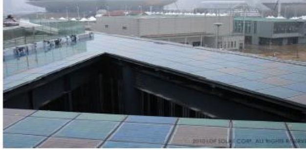
استخدام الخلايا الشمسية الملونة في الممرات الخارجية و سطح معرض إكسبو العالمي ٢٠١٠ بـسنغهاي ١
