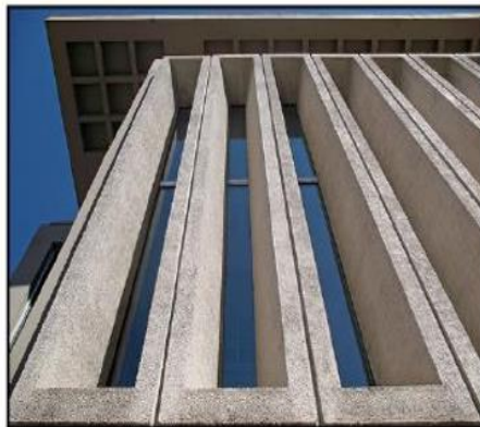
استخدام الوحدات الخرسانية سابقة التجهيز في تكوين الغلاف الخارجي بأحد المباني المكتبية بمدينة دنفر الأمريكية - للمعماري ويليام موشو William Muchow Denver, USA
