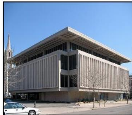
استخدام الوحدات الخرسانية سابقة التجهيز في تكوين الغلاف الخارجي بأحد المباني المكتبية بمدينة دنفر الأمريكية - للمعماري ويليام موشو William Muchow Denver, USA
