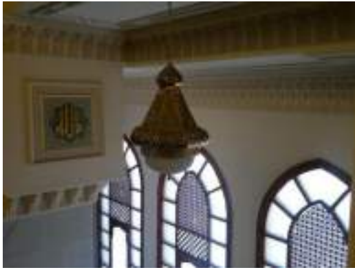
شكل(٣-١٤٠): يوضح المقرنصات على جانبي الكمرات المشكلة لأسقف المسجد
