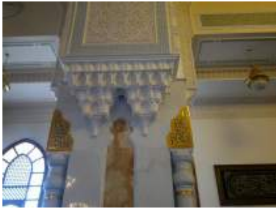
شكل(٣-١٤١): يوضح المقرنصات المستخدمة على جانبي العمود بالمسجد
