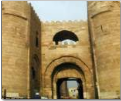
شكل(٢-٤) استخدام العقود أعلى البوابه مما يزيد من متانه البناء ١
