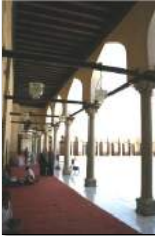
شكل(١٥٢-٢) توضح الاكتاف الحاملة للعقود الموجودة بالاروقة المشرفة على الصحن ١
