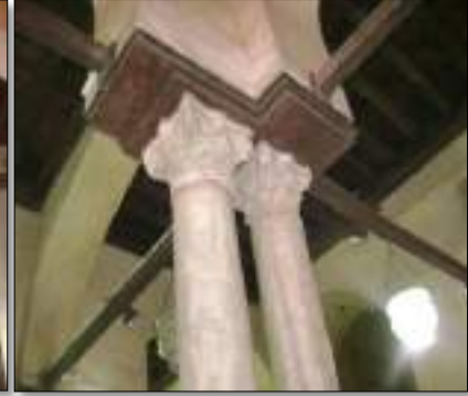
شكل(١٥١-٢): يوضح الميد الخشبية التي تربط الاعمده ببعضها البعض ١
