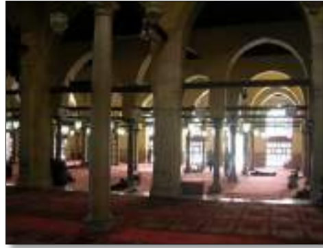
شكل(٢-١٤٣):صورة العقود الداخلية للايوان محملة على الاعمدة الرخامية ١
