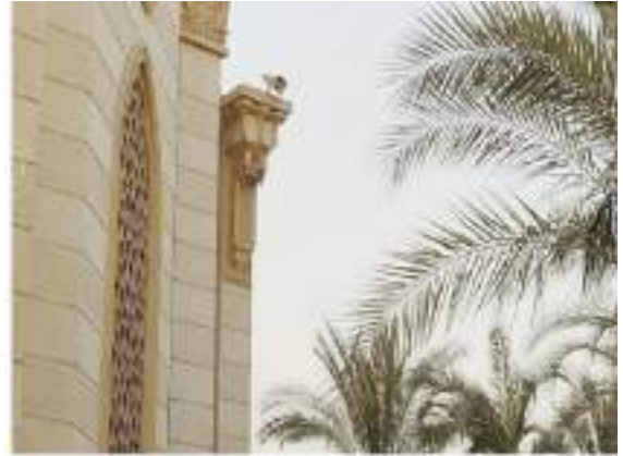
شكل (٨٨-٣): يوضح الكوابيل المستخدمة أعلى المداخل
