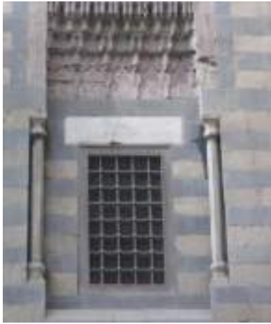
شكل (٢-١٩٧) يوضح القوصرات الطويلة بالنوافذ للواجهة البحرية ١
