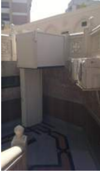
شكل (٣-٣٧): يوضح المصعد الكهربائي المؤدي للدور البدروم لقاعات المناسبات
