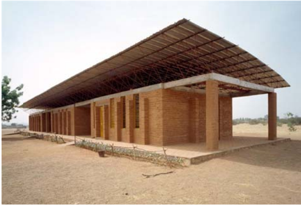
شكل ٢-١٣ مبنى مدرسة ابتدائي / بوركينا فاسو - أسطورة البناء حيث يشترك الجميع في تشييد المبنى الذي يقدم خدماته لكافة السكان المصدر: www.akdn.org
