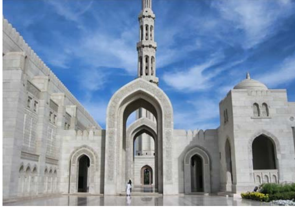
شكل ١- ١٧ أحد اعمال المعماري محمد مكبة الذي عمل فيه على دمج المفردات التراثية بالمبنى وإن كان المبنى في استخدام كمسجد يطابق الكثير من المباني التراثية مسجد السلطان قابوس - محمد مكبة المصدر: www.worldarchitecture.org
