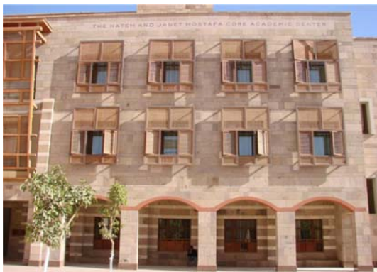
شكل ٥- ٢٠ الاستخدام المكثف للمشربيات الخشبية على الواجهة الغربية لمبنى المركز الأكاديمي المصدر : الباحث
