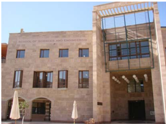
شكل ٥- ٢٧ إمالة الفتحات في الواجهة الشرقية لمبنى كلية الهندسة للاستفادة من التوجيه والإضاءة المصدر : الباحث
