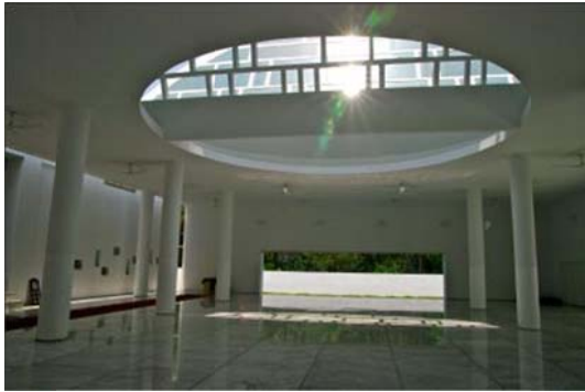
شكل ٤-٤٩ الأسلوب التجريدي للقبّة وتحويلها إلى عنصر حدائثي يهتم بتوفير الإضاءة داخل فراغ الصلاة المصدر: www.akdn.org
