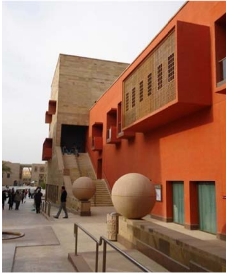
شكل ٥- ٣٥ استخدام الطبيعة الإنشائية للمواد الحديثة مثل الخرسانة في تكوين صورة معاصرة من الكوابيل التي أستخدمت بالعمارة الإسلامية المصدر: الباحث
