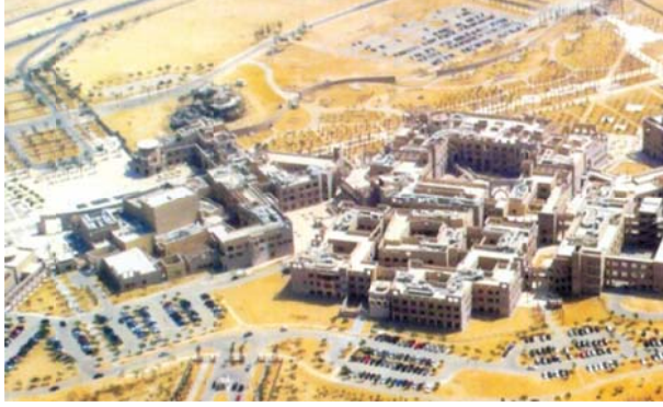
شكل ٥- ٣٧ الترابط البصري والكتلي بين مباني المرحلة الأولى حتى أنها تظهر في صورة مبنى واحد لا يمكن تقسيمه بالرغم من التعددية الوظيفية والتشكيلية المصدر: عرفة أبو المجد ، ٢٠١٠
