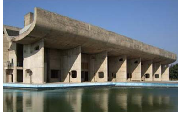
شكل ١-١ أعمال لوكوربزيه والتعامل المختلف مع الموقع والاهتمام المتزايد بالوظيفة المعمارية قصر العدالة - شانديغار - المعماري: لوكوربزيه - ١٩٥١ المصدر : www.en.wikipedia.org
