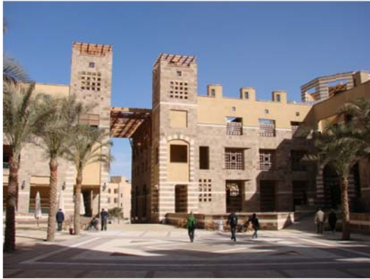
شكل ٥- ١٦ استخدام ملاقف الهواء في مبنى الإدارة لتوفير التهوية الجيدة للفراغات الخاصة بالمبنى المصدر : الباحث
