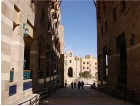
شكل ٥ - ٧ فرق المنسوب بين ساحة مبنى الإدارة والممر أمام مبنى مركز البحوث وطبيعة تعامل المصمم معه بتكوين دور خدمي آخر وعمل ممر في منسوب الأرضي المصدر: الباحث
