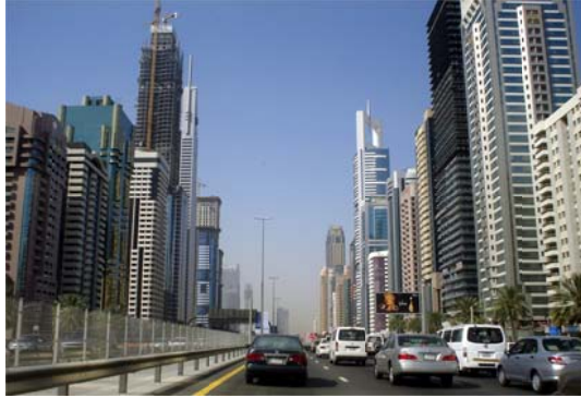
شكل ٣- ١٩ تأثير مركز المدينة على الطابع المعماري للمباني نتيجة للنزعة الإستهلاكية شارع الشيخ زايد - دبي المصدر: www.citypictures.org
