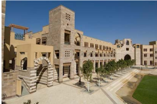
شكل ٥- ٥٥ بالرغم من استخدام التكوين الأبلق في تشكيل الواجهات والتفاصيل التراثية إلا أن ذلك لم يشفع لمبنى مركز الأبحاث كونه مبنى حداثي على المستويين الكتلي والوظيفي المصدر: الباحث
