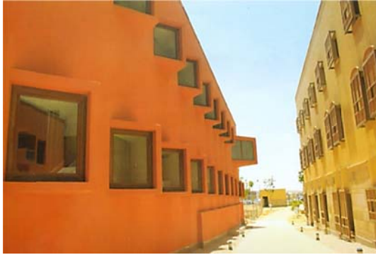
شكل ٥- ٢٦ إمالة الفتحات في الواجهة الجنوبية لمبنى مركز الحرم للاستفادة من التوجيه والإضاءة المصدر : عرفة ابو المجد ، ٢٠١٠
