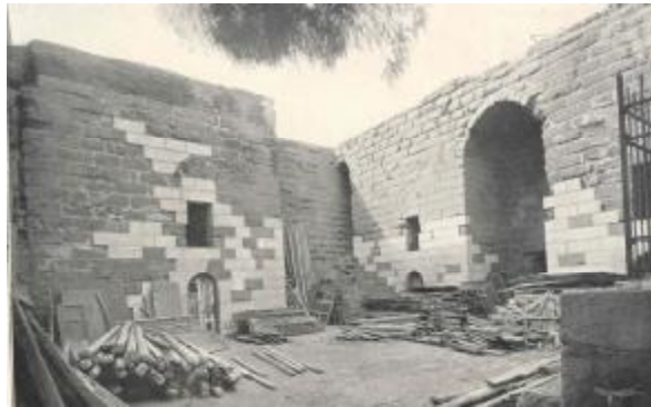
صورة رقم ٨٥،٨٤ صحن مدرسة السلطان حسن قبل عملية الترميم و أثناء تجهيز أعمال الصلبات والتأمين في بداية عملية الترميم، أرشيف لجنة الحفاظ على الآثار العربية
