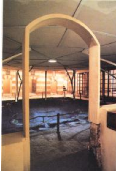
صور رقم ٩٤،٩٣ إلى اليمين مسرح الدراويش أثناء افتتاحه بعد أعمال الترميم وإلى اليسار الهياكل المعدنية لتثبيت والعقود المعدنية المماثلة للتصميم القديم لهذا الجزء من مدرسة سنقر السعدي واستخدام المعدن لتمييز القديم من الجديد، مدرسة سنقر السعدي والمتحف المولوي (٢٠٠٠)
