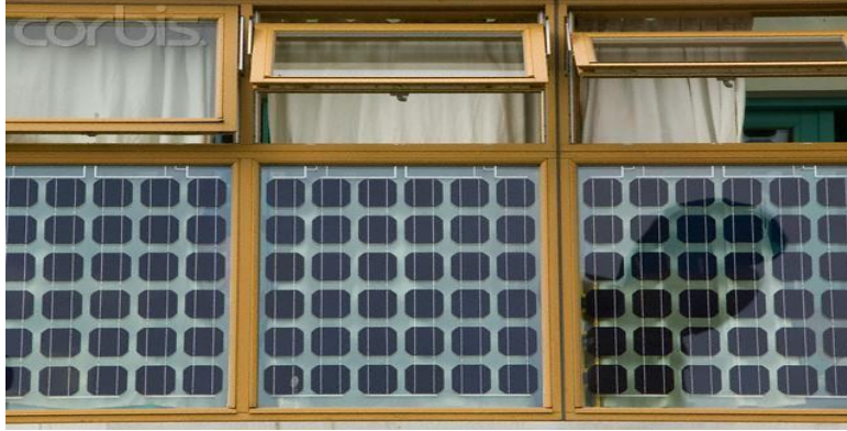
يوضح الشكل النوافذ الشمسية في BedZed ، أكبر قرية بيئية في المملكة المتحدة ، وأكبر قرية بيئية لأسلوب حياة مستدام بدون انبعاثات كربونية
