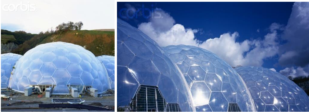
يوضح الشكل قباب Eden لمشروع المملكة المتحدة المصنوعة من ETFE (رقائق قابلة لإعادة التدوير)
