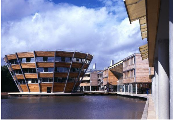
يوضح الشكل استخدام البحيرات لتبريد مباني جامعة نوتنغهام - المملكة المتحدة
