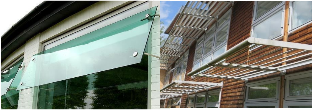
يوضح الشكل عاكس الضوء للتحكم في الإشعاع الشمسي ، لتحسين ضوء الشمس وتقليل الحاجة إلى الإضاءة غير الطبيعية
