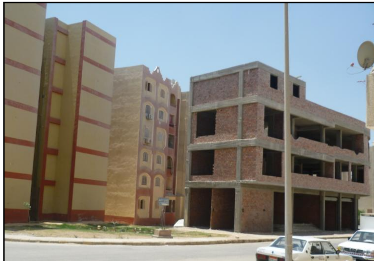
شكل (١٣-٥) - مركز تجاري "مول عمارات الفرسان" تحت الإنشاء المصدر: الباحثة
