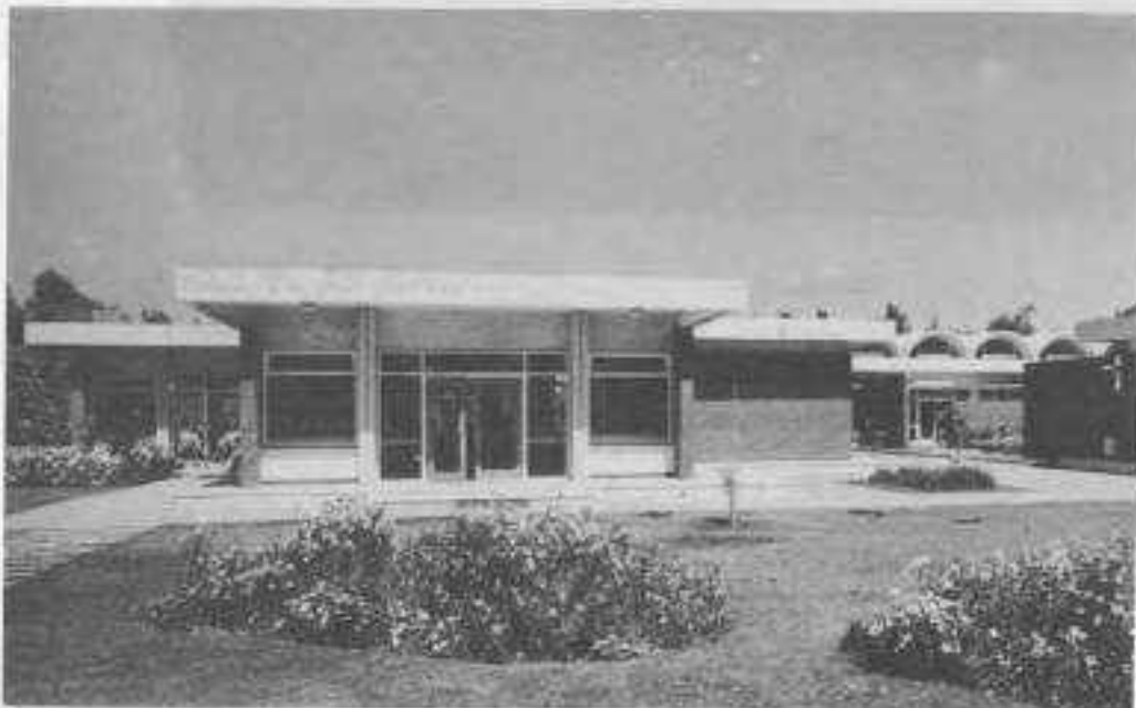
● مبنى روضة الأطفال
