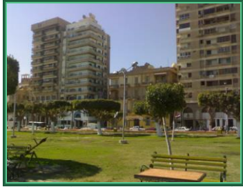
شكل رقم (139) يوضح حداثة المباني الموجودة على المسطاح بعد فتح المسطاح للعامه.
