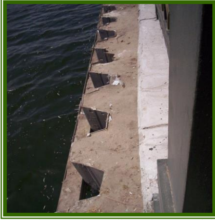
شكل رقم (99-100) يوضحاً تثبيت التربة وتدعيم جسر نهر النيل بحواجز الحماية للحفاظ على مباني الواجهة النهرية بمحافظة دمياط من الانهيار بعد تغلغ المياه اسفل التربة.
