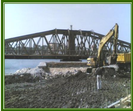
شكل رقم (103) نقل الكوبري إلي الموقع الجديد عائمًا علي صفحة النهر. شكل رقم (104) الجزء المتحرك من الكوبري تم نقله وثنيته في المكان المحدد له.
