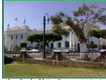
شكل رقم (142) مبنى المحافظة على المسطاح والذي تم بناؤه حديثاً.
