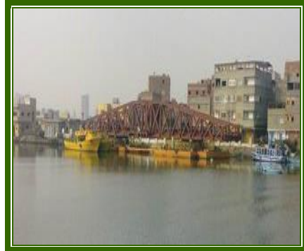
شكل رقم (103) نقل الكوبري إلي الموقع الجديد عائمًا علي صفحة النهر. شكل رقم (104) الجزء المتحرك من الكوبري تم نقله وثنيته في المكان المحدد له.
