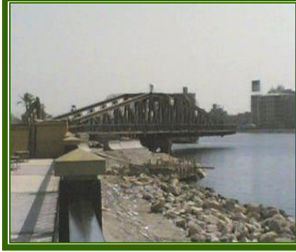
شكل رقم (105) موقع الكوبرى الجديد على مسطح دمياط بعد نقله من مكانه القديم بداخل دمياط.
