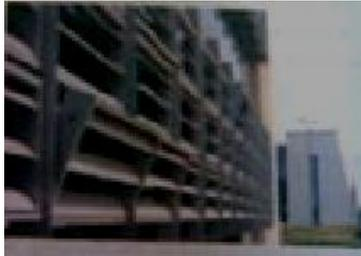
شكل رقم (3-92) استخدام الكاسرات الشمسية لتقليل الاكتساب الحرارى
