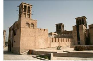
شكل رقم (2-92) ملاقف الهواء
