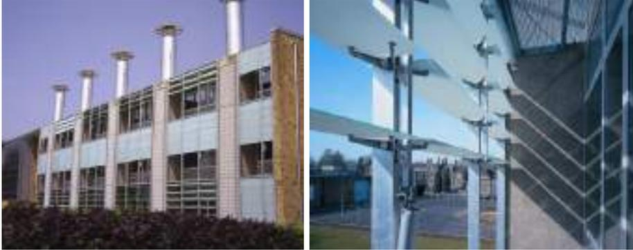
شكل (٣-٤٨): الشرائح الزجاجية الدوارة (Rotting glass louvers) التي يمكن لها التحكم
