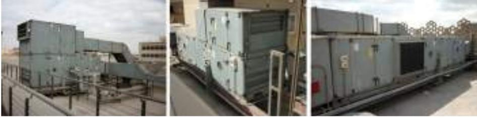
شكل ( ٣-٨٣): نظام التكييف الذى تعتمد على تبريد المياه Chilled-water Air Condition الموجود على سطح المبنى (المصدر: الباحث)
