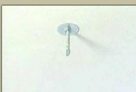
(4) بعد التأكيد من تثبيت التيش « الهنجر » وربطه جيدا بالسقف اثبتك به سلك الرياط الذى سوف يحمل العوارض البلاستيكية الحاملة لل بلاطات .
