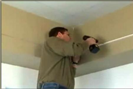
(3) يتم تركيب التيش في نقاطه المحددة مسبقا في السقف ، ويتم التأكيد من تثبيت الفيشراو حامل قوى تثبيتا جيدا لانه هو الحمل الاساسى على السقف وهو نقطه ارتكاز السقف و اذا كان مرتخيا تسبب في انهيار السقف .
