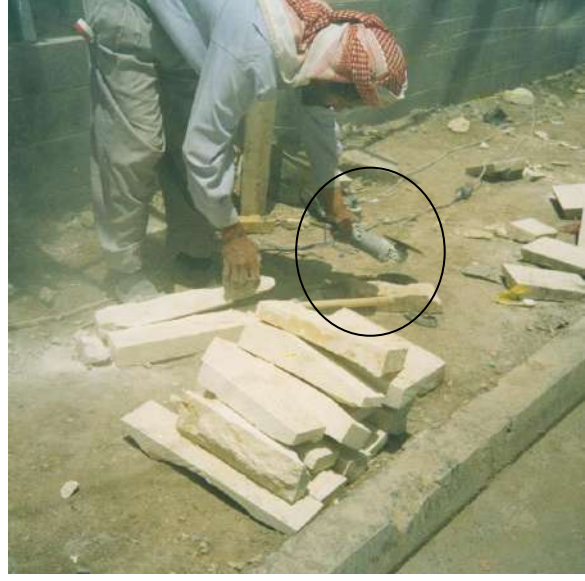
شكل ( ٧-٥ ) استخدام التقنيات الجديدة في قص الأحجار والوصول إلى الأشكال المعقدة .
