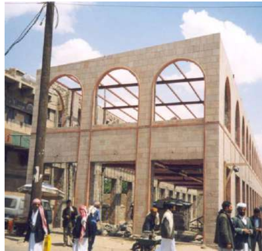
تكسية الهيكل الحديدي بالأحجار
