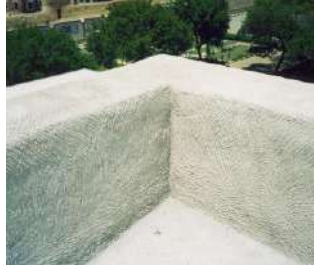
تخشين الطبقة الأولى للقضاض كتهيئة لوضع الطبقة الثانية
