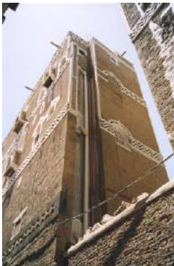
شكل (٢-٤٠) معالجة الصرف الصحي بطريقة فنية دليل على الاهتمام بتشكيل الواجهات
