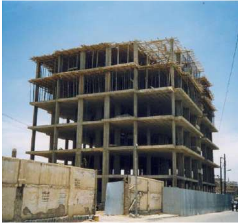
شكل ( ٥ - ٣ ) تشييد الهيكل الخرساني وتسليحه .
