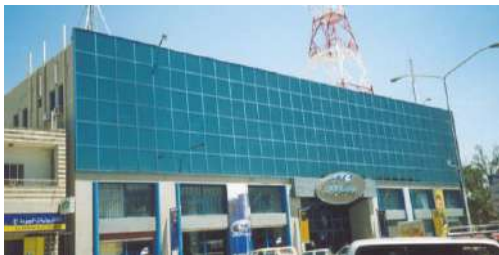
تكسية الهيكل الحديدي بالزجاج والمواد المعدنية
