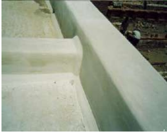
الشكل النهائي للسطح بعد عمل الطبقة الثانية وطلاءها بالدهان .
