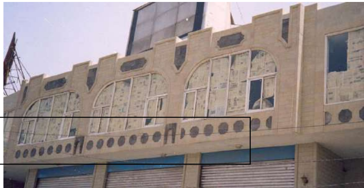
صياغة العنصر التقليدي المشربية بشكل مبسط وغير وظيفي ووضعها في غير مكانها الصحيح ، بالإضافة إلى صياغة العنصر الأفقي ( الحزام ) بطريقة مبسطة وغير موفقة .
