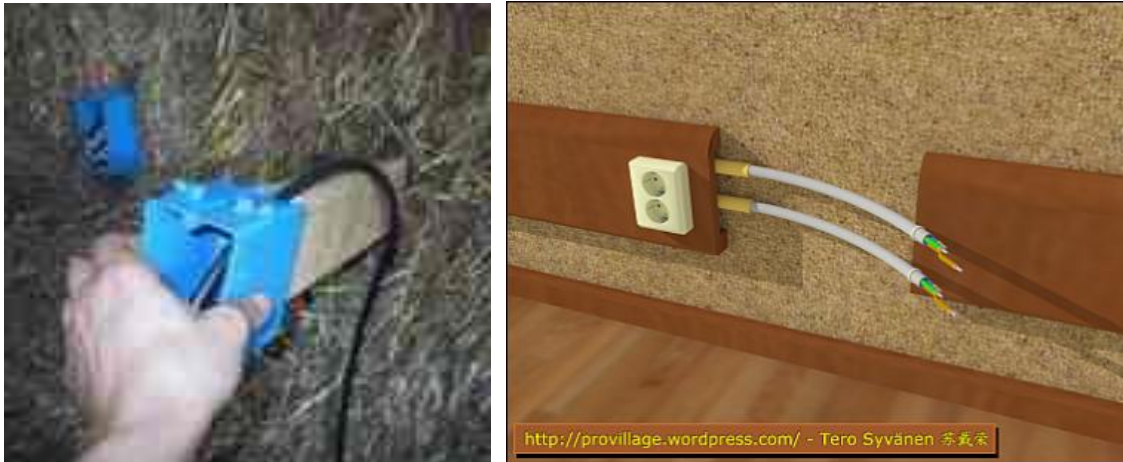
شكل (124) 4 علب خشبية يتم تثبيتها بالجدران بالمسامير بعد التشطيب و تثبيت أدوات الكهرباء في هيكل بالات القش.
