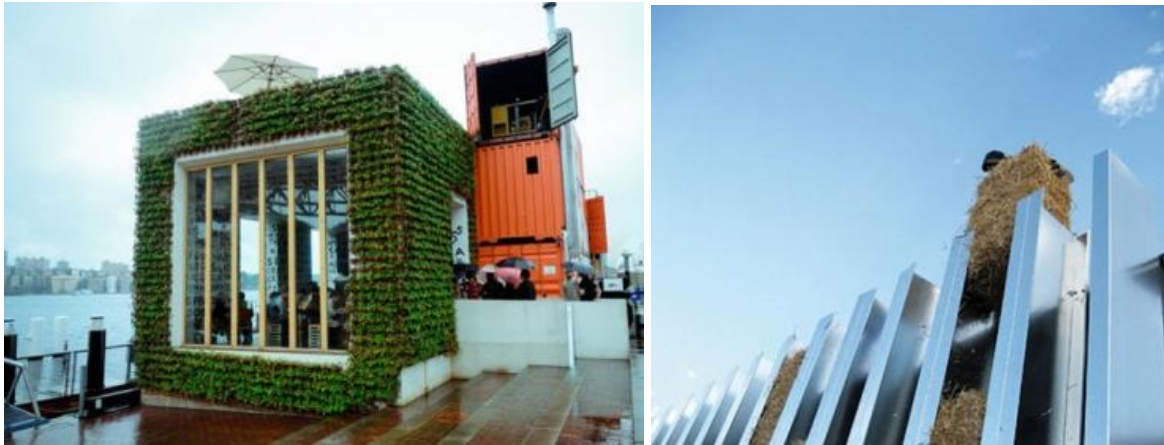
شكل (115) 3 يوضح بناء الجدار الخارجي للمطعم من بالات القش ، داخل إطار من الأستيل الخفيف .
