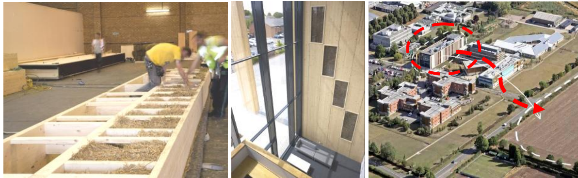
شكل (135) 3 يعرض مكان الحقل الذي أستخدم منه القش وطريقة بناء حائط بالآت القش وإظهاره في الفراغ الداخلي.
