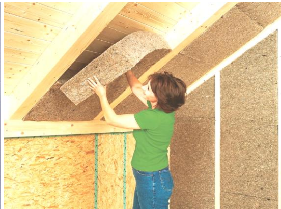
شكل (82) يوضح استخدام ألياف القنب المستخدمة في العزل على هيئة بلاطات .
