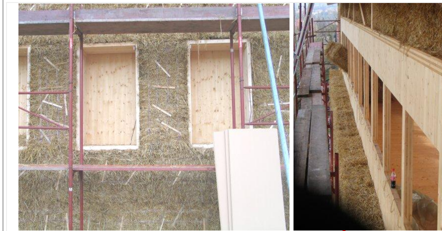
شكل (114) 3 يوضح مراحل استخدام بالات القش في العزل ، وتكديسها بين الإطارات خشبية وكيفية المعالجة الخارجية بتكسية الحوائط الخارجية بالأخشاب.
