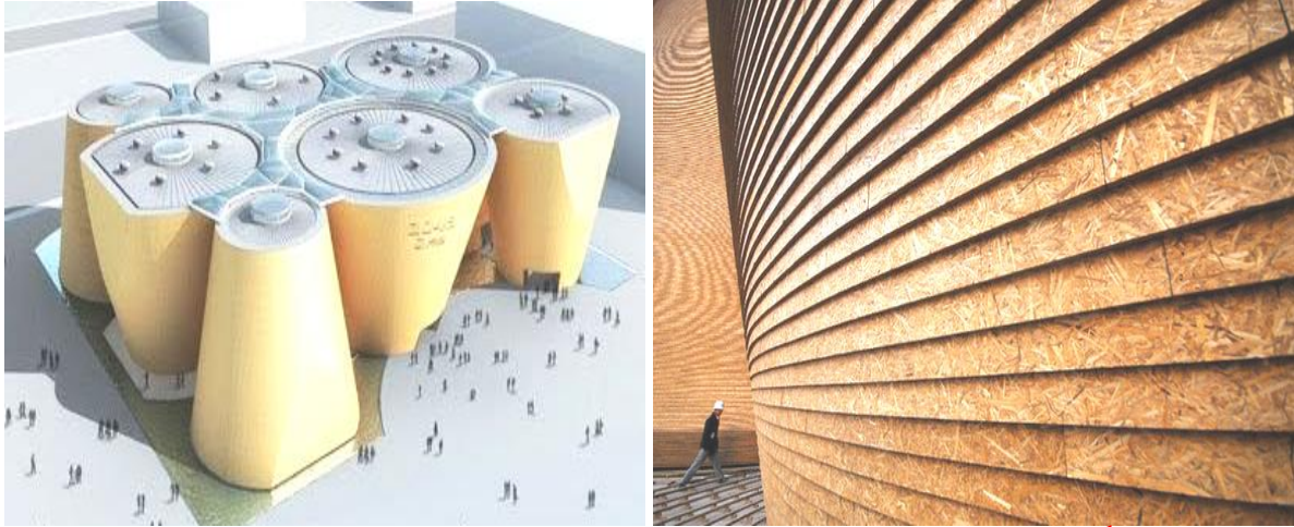
شكل (148) 1 يوضح ألواح القش المضغوطة بتصميمها الذي يسمح بمرور الهواء ، كما توضح تصميم السقف الأزرق الشفاف و المياه المحيطة بالمعرض على شكل دائري .
