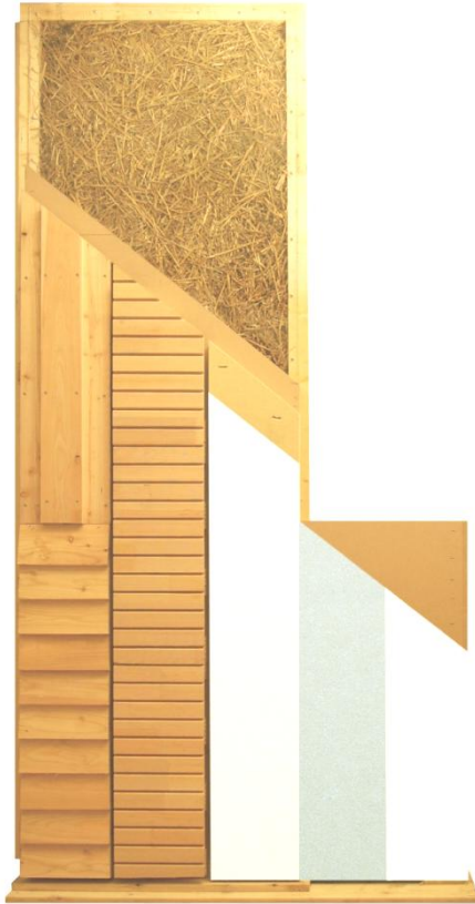
شكل (41) يوضح طريقة تشطيب حوائط بالات القش سابقة التجهيز ، فإما تكسيتهما بألواح خشبية بطريقة واسعة ، أو طلاءها وتليسه مباشرة بالجص ثم باللون المناسب ، مع مراعاة ضرورة أن يكون اللون معالج .
