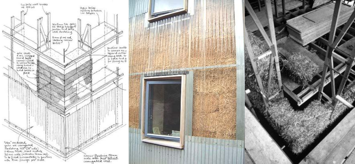
شكل (122) 3 يوضح بناء حوائط بالات القش في منطقة غرف النوم وتكسية من ألواح الأستيل والأكريليك المعاد تدويره .
