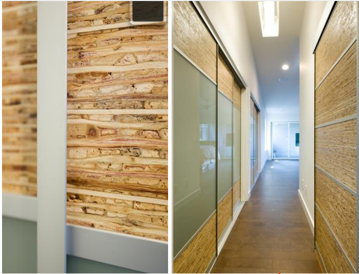
شكل (175) 1 يوضح تصميم أبواب مشروع " Tree House " بالكامل من ألواح " Kireiboard " وتثبيتها بإطارات من الأستيل .
