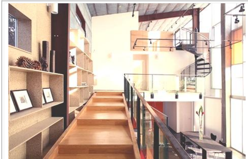
شكل (184) 2 يوضح استخدام ألواح بذرة عباد الشمس " sunflower seeds " في تكسية حائط الممر/الكوبري الذي يصل بين جانبي الدور العلوي للمنزل .
