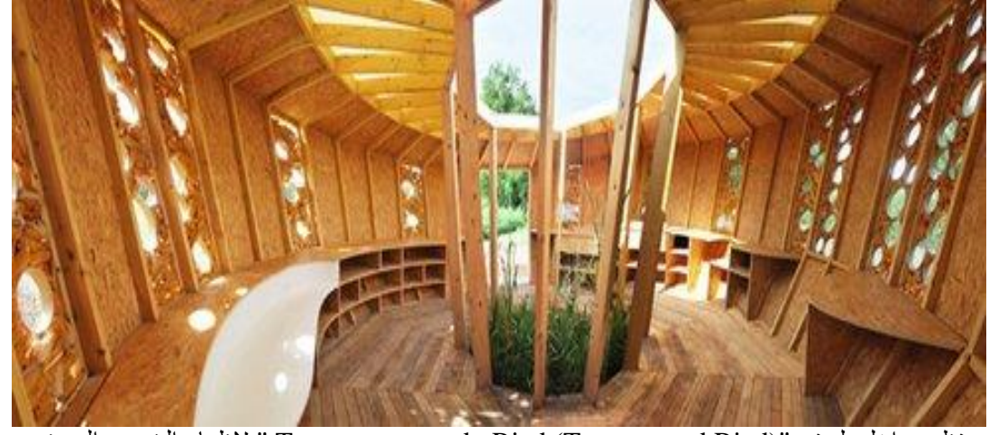
منظور داخلي لمبنى " Tourner autour du Ried (Turn around Ried) " لإظهار التصميم المسيرتر لوحدات الأثاث بلونها الأبيض والخشبى ، بسمك الحوائط والمنطقة الوسطى المفتوحة وطريقة تركيب السلك المعدنى فى الحائط الخارجى وأتصال السقف بالحوائط .
