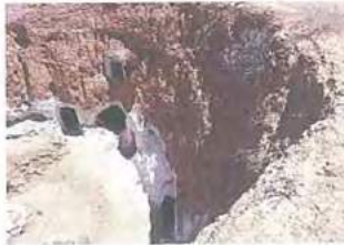
شكل (٧٦) البناء بالمواد المحلية المصدر: بتصريف الباحثه .
