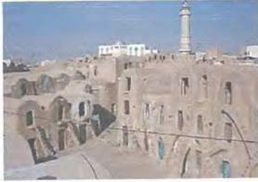
شكل (٧٤) يوضح البناء تحت منسوب الارض للحماية من الاشعاع الشمسي المصدر: بتصريف الباحثه
