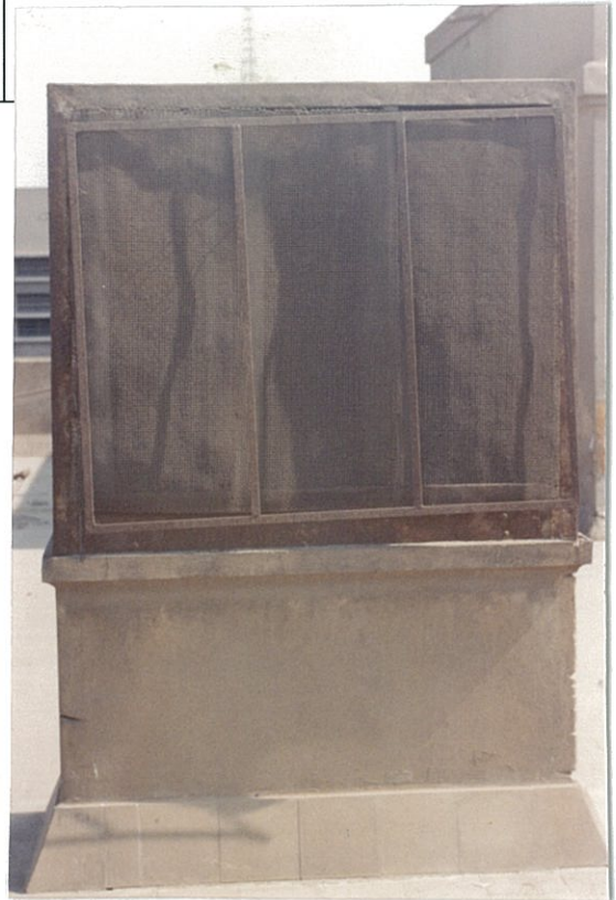
(شكل ٢٠٩) الملقف الثلاثى الشرقى أ - فتحات دخول الهواء الثلاثيه على السطح والمغطاه بغطاء سلك ب - فتحات خروج الهواء الى الفراغ ومغطاه بغطاء معدنى مخرم (الفتحة المزدوجة بغرفه المدير).
