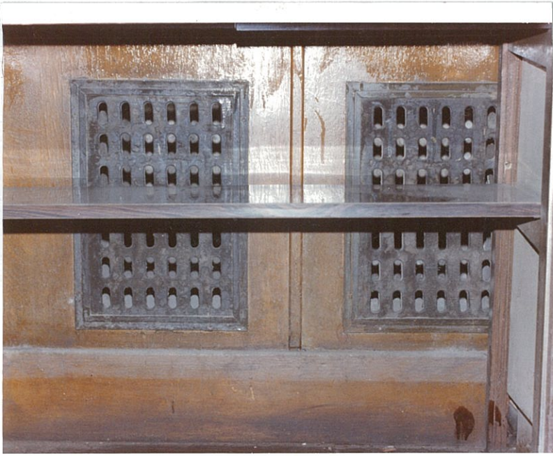
(شكل ٢٠٩) الملقف الثلاثى الشرقى أ - فتحات دخول الهواء الثلاثيه على السطح والمغطاه بغطاء سلك ب - فتحات خروج الهواء الى الفراغ ومغطاه بغطاء معدنى مخرم (الفتحة المزدوجة بغرفه المدير).
