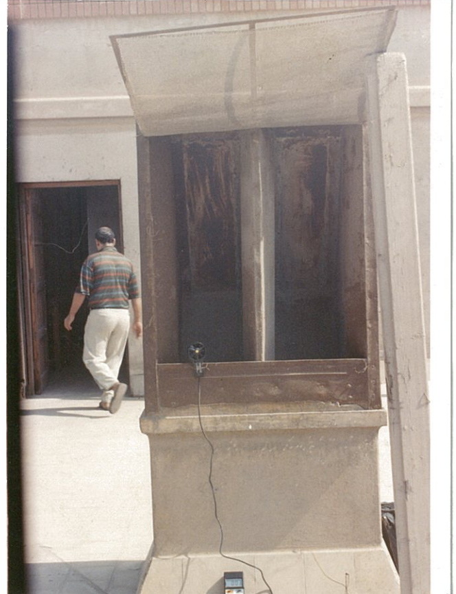
(شكل ٢٠٨ أ) - الملقف المزدوج الغربى وفتحتى دخول الهواء على السطح ،
