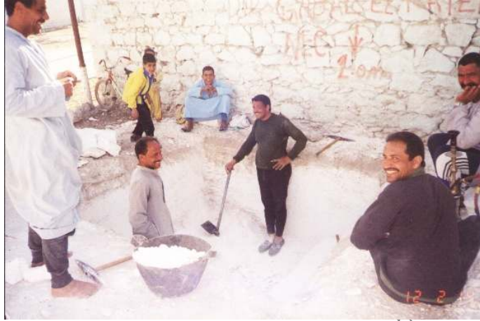
شكل 45 عملية البناء تتم بشكل تعاوني متكامل في القرية المصرية.
