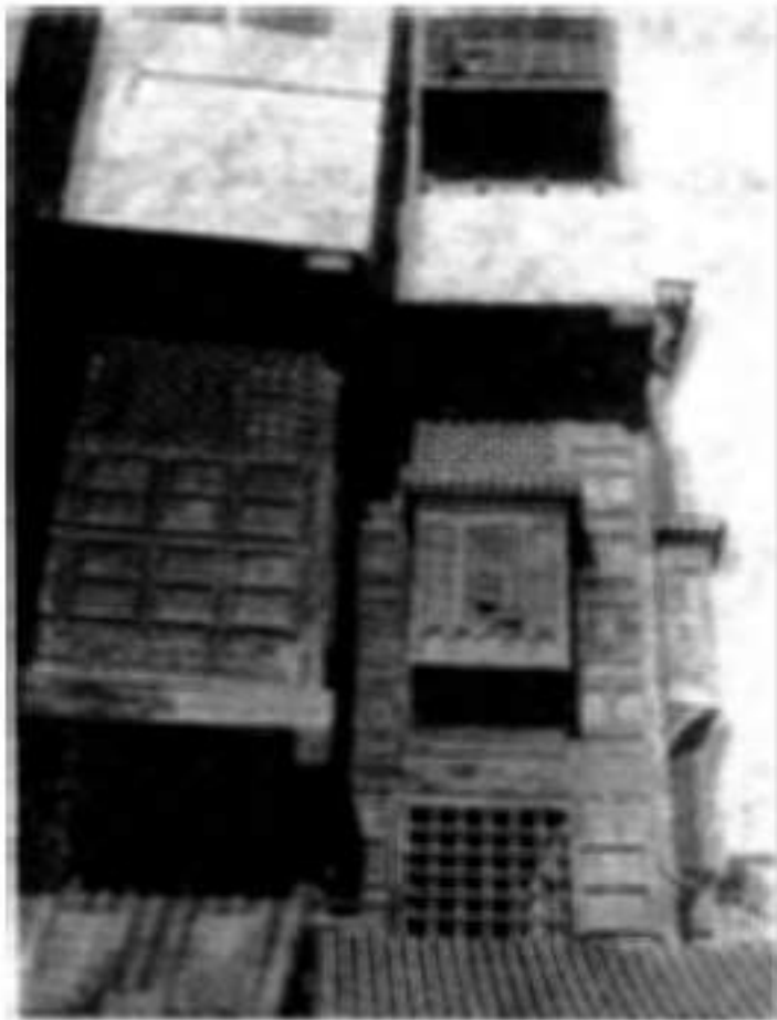
مجموعة من أعمال النجارة لاحد الاركان في مبنى قديم
