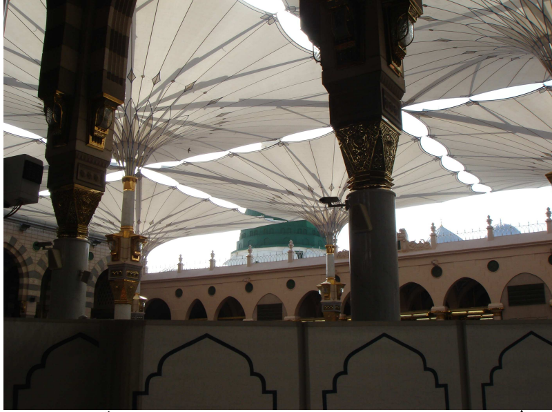
شكل (٤٣-٥) ١ - مظلات الفناء الداخلي بالمسجد النبوي وهي مفتوحة، ونلاحظ ارتفاعها فوق منسوب سقف المسجد بمسافة تسمح بدخول وخروج قدر من الهواء والأشعة الشمسية.
