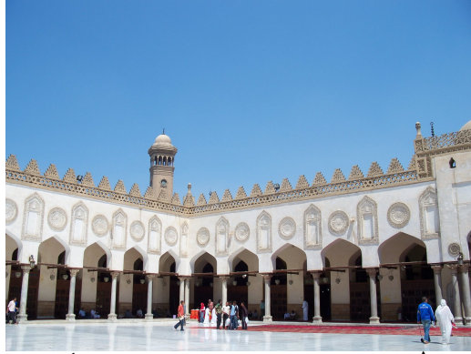
شكل (٢-٦٢)١ - الفناء الداخلي بمسجد الجامع الأزهر - القاهرة.
