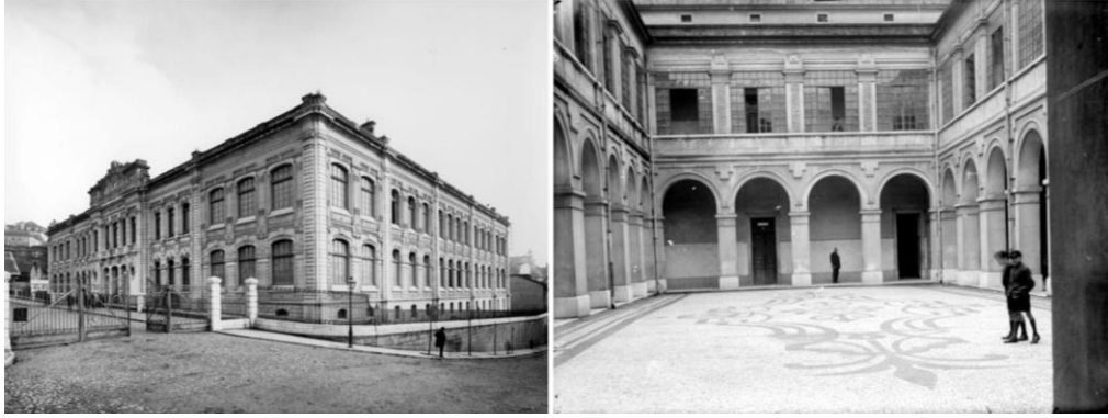
شكل ٢٧-١ ، مدرسة باسوس مانويل الثانوية في البرتغال ( Passos Manuel Secundry School ) ، Alexandra Alerge ، ٢٠١٢،
