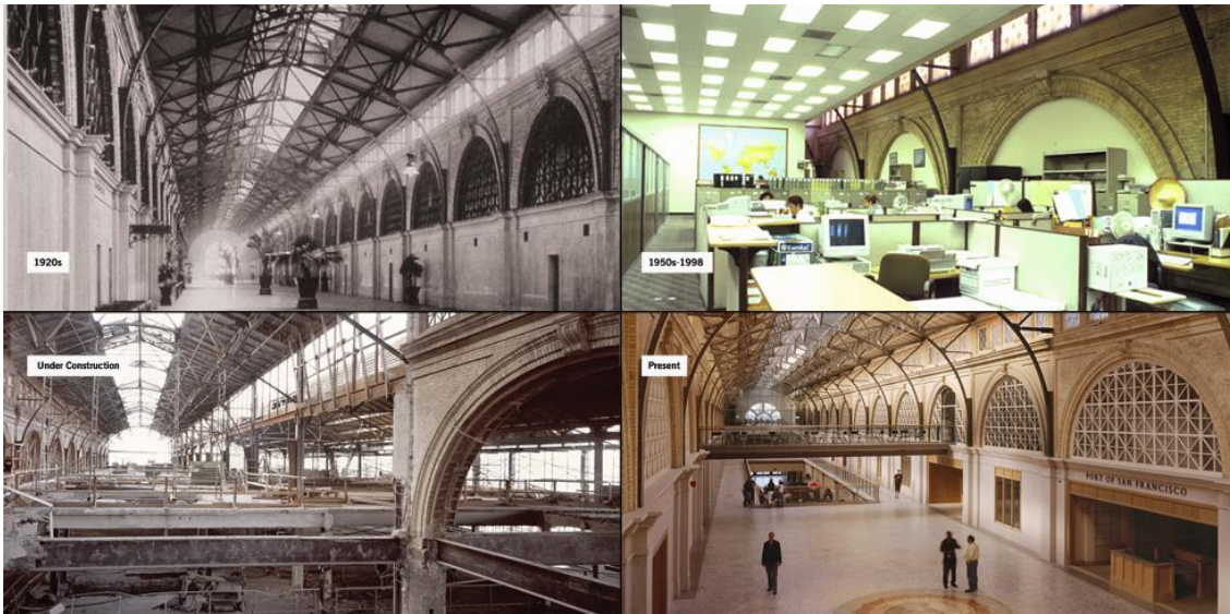
الشكل ٣-٥٠ مبنى فيرى قبل وبعد إعادة التوظيف
