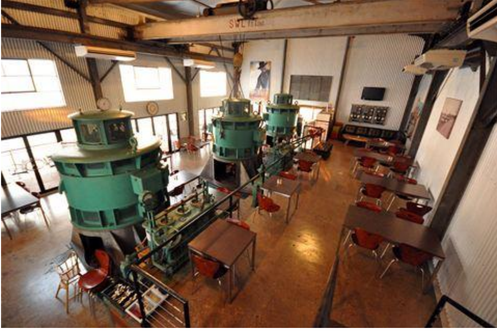
الشكل ٥٧-٣ محطة ضخ مياه غرب أستراليا من الداخل http://www.thepumphouserestaurant.com/Photo-gallery.html
