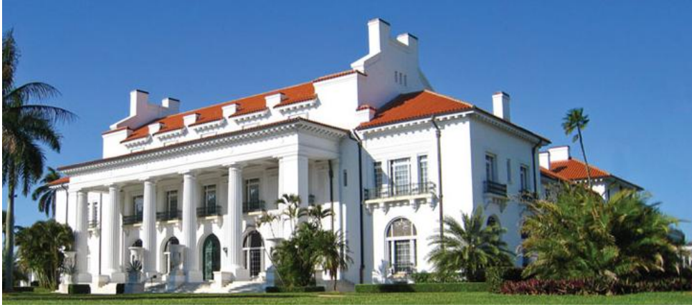
الشكل ٣-٤٤ منزل هنري فلاجلر الذي تم إعادة توظيفه كمتحف
