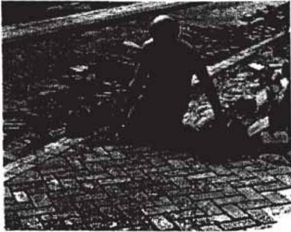
(شكل ٢-٤٨) تثبيت وحدات حرسانية بدون مونة بطريقة التعشيق Inter locking
