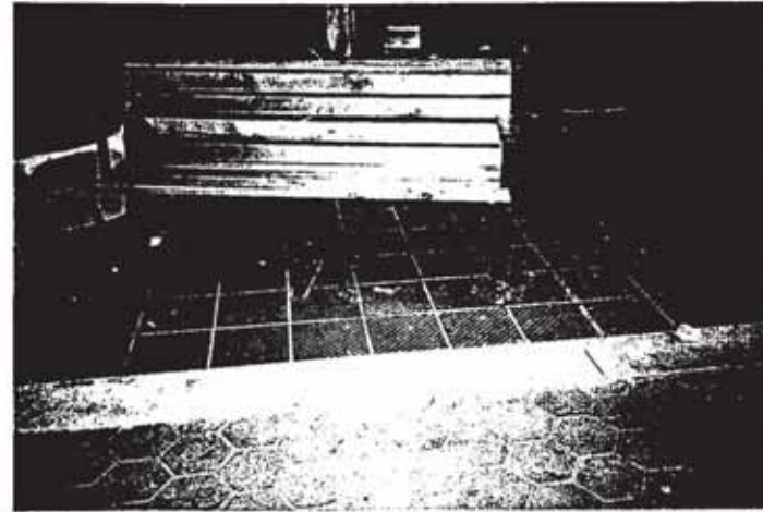
(شكل ٢-١٤٦) المقاعد الخشبية المستخدمة لم يتم تثبيتها بشكل جيد مما يؤدي إلى تحريكها
