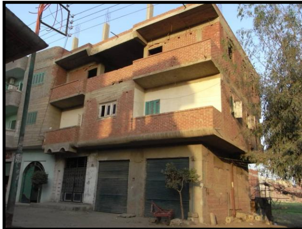
شكل ٣-٤ : لقطة توضح الواجهة الرئيسية للمسكن
