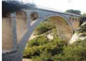
Viaduc des Eaux-salées - France - 50m
