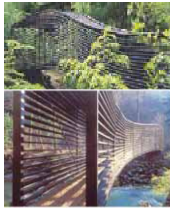
Boudry bridge, Suisse
