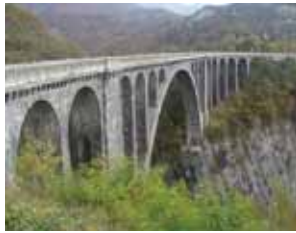
Viaduc de la Roizonne - France 79m
