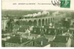
Viaduc de Nogent-sur-Marne - France - 50m
