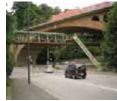
de onnborner Eisenbahnbrücke - Germany 66m 2
