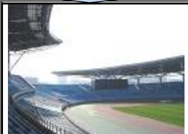
Fig (1-40) The Hefei Stadium in Hefei-China
