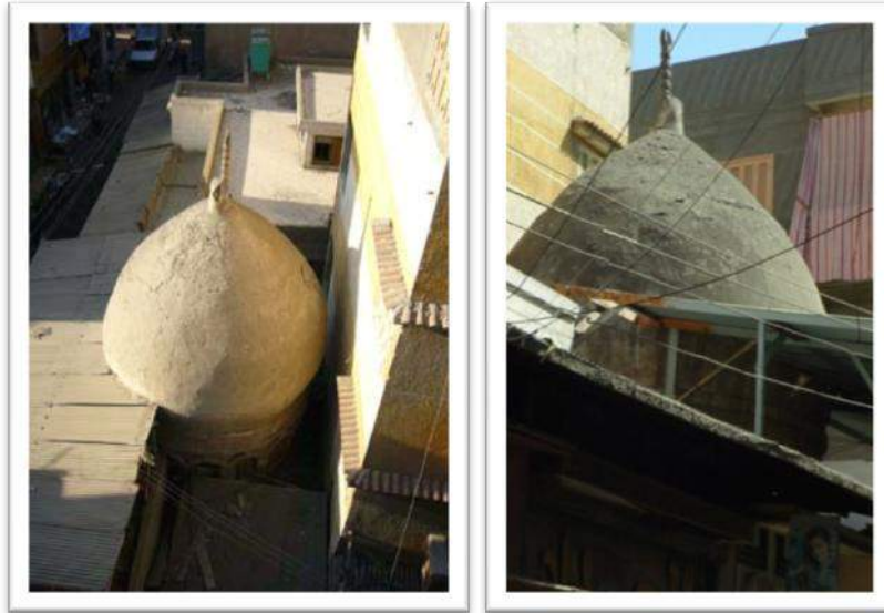
(Pl. CXV) Dôme de ǧarīḥ al-Amīr Gaʿfar al-Silīhdār
