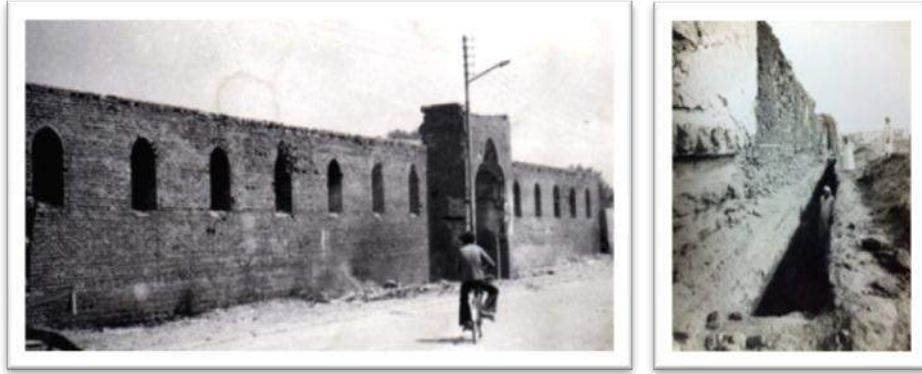
(Pl. XLIX) Le mur extérieur après la restauration au XX e siècle
