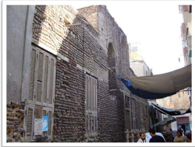
(1) Bâtiment en face de la mosquée ibn al-Nfis
