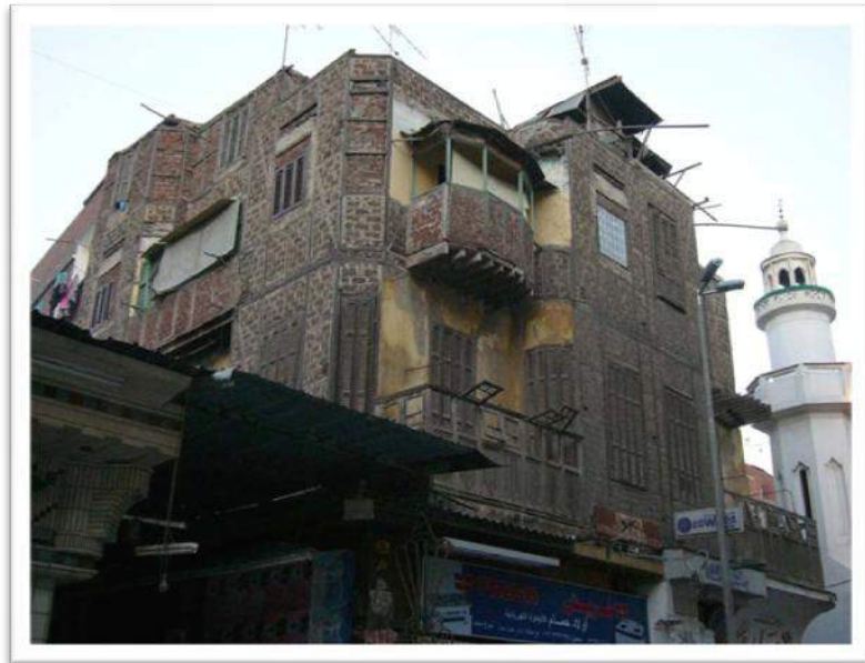
(5) Maison à coté de la mosquée Abū Qaribah
