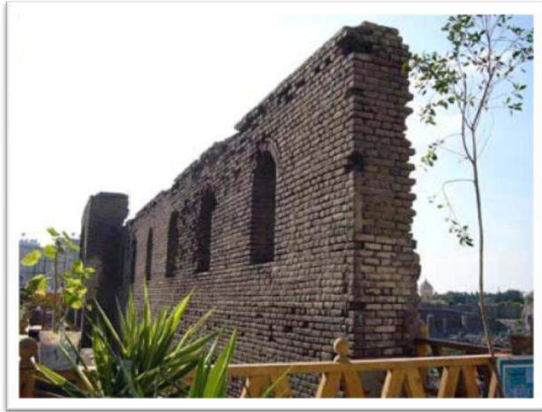
(Pl. LI) L'épaisseur du mur extérieur en 2005
