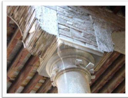
(Pl. CXIII) Une colonne en marbre porte le plafond d'al-hilwa en bois
