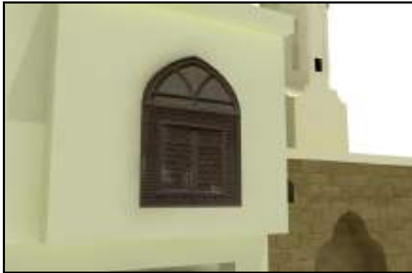
(Fig. 98) La fenêtre sur la façade principale couverte par bois tourné
