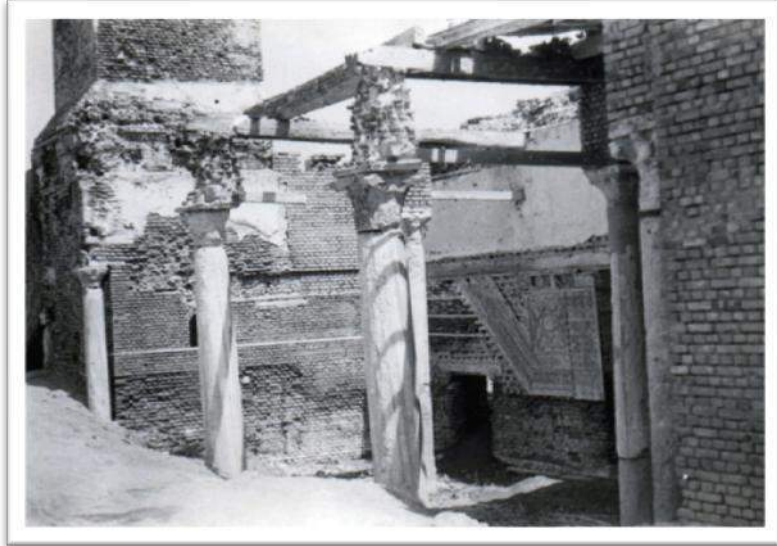
(Pl. LVI) L'entrée de la façade ouest
