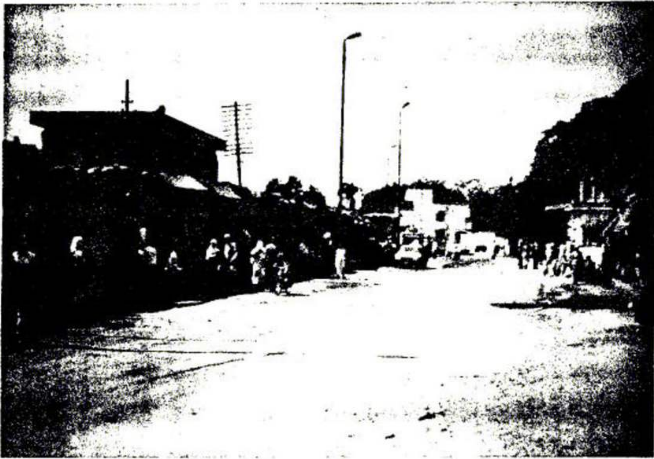
36- Implantation des petites installations de commerce tout le long de la ligne. La rue ci-dessus est celle qui longe le métro.
