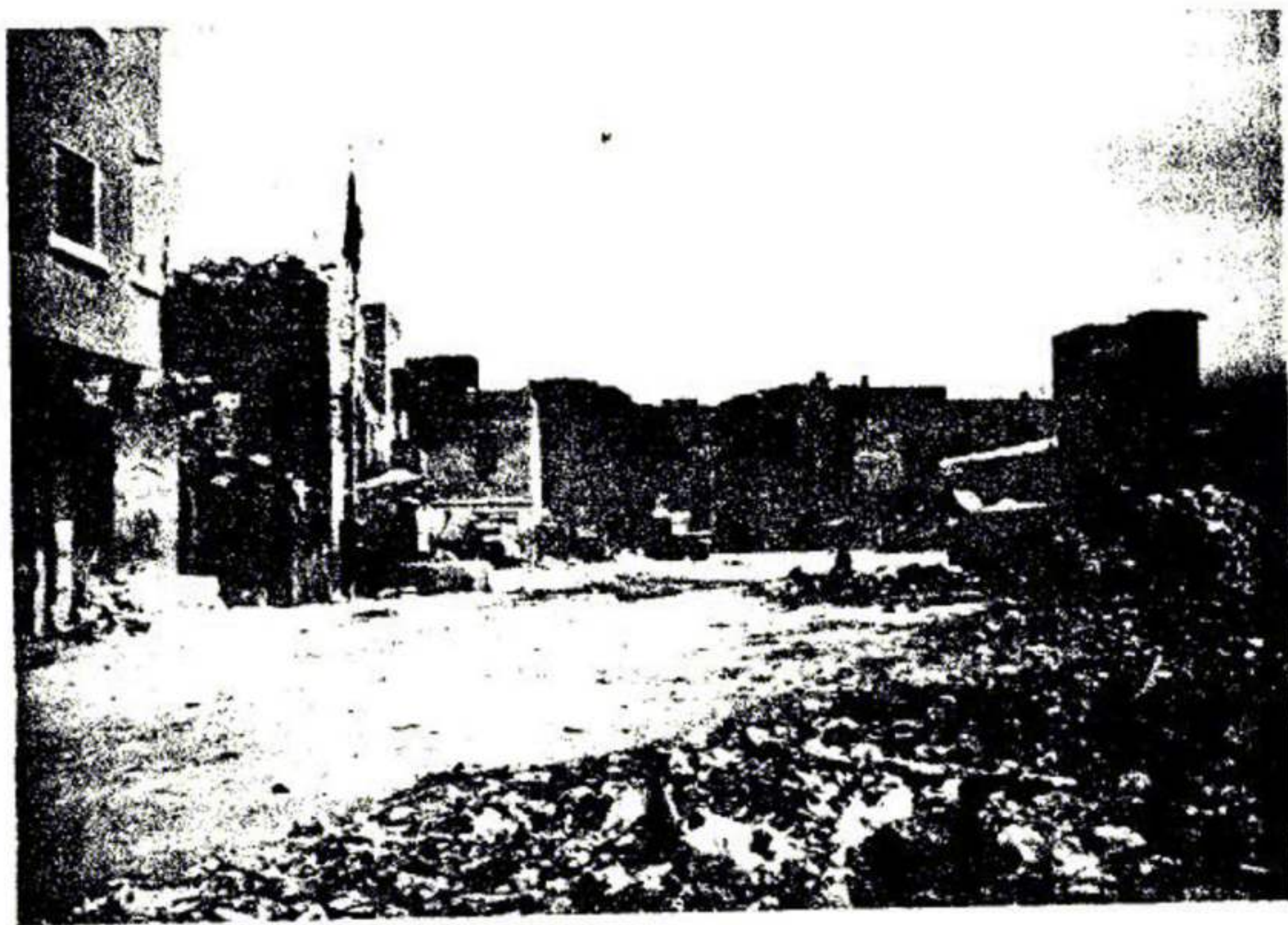
22- Zone dégradée à proximité de la station Kotsika
