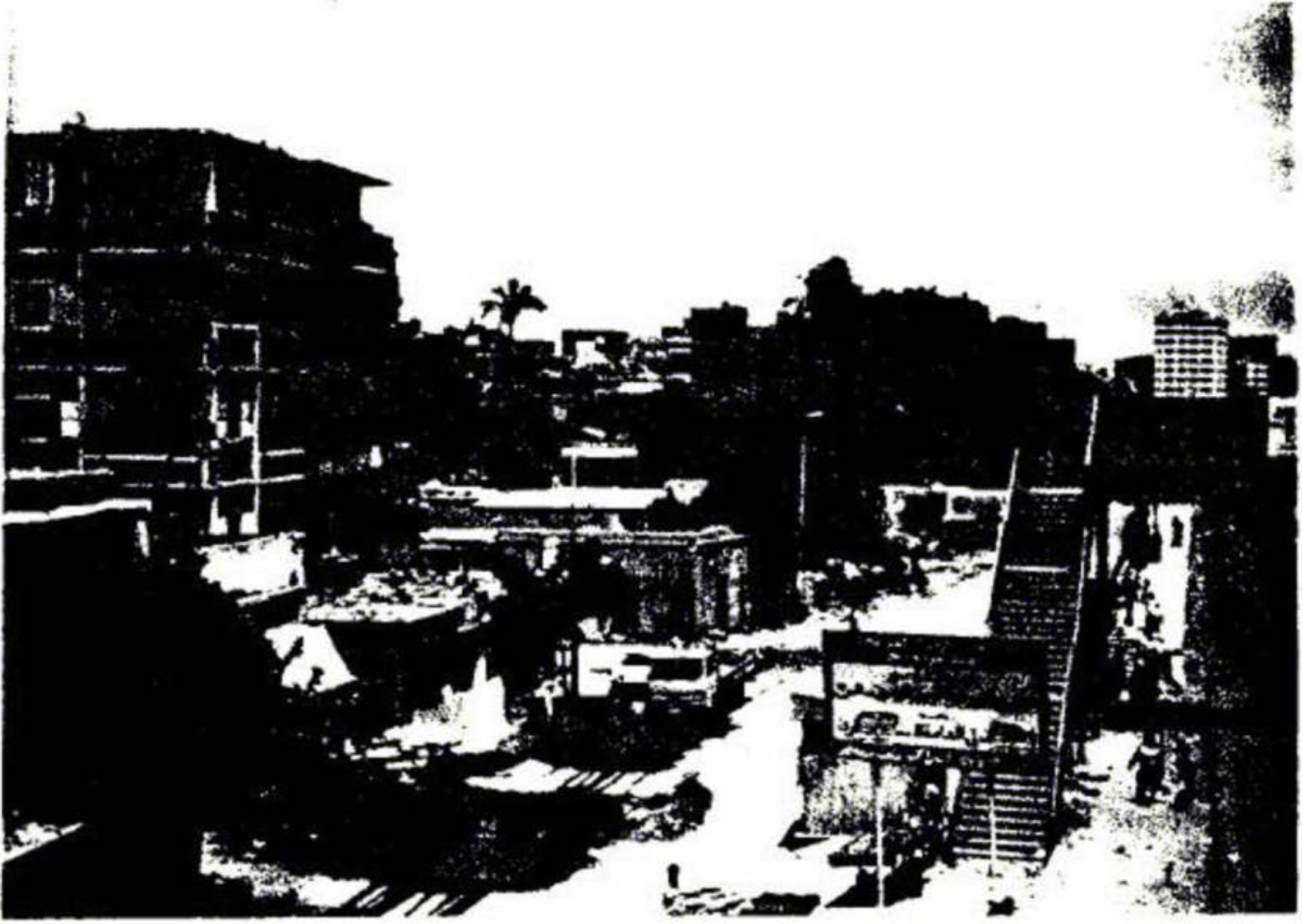
37- Vue de la station Ein Chams, et l'implantation des ZUS.
