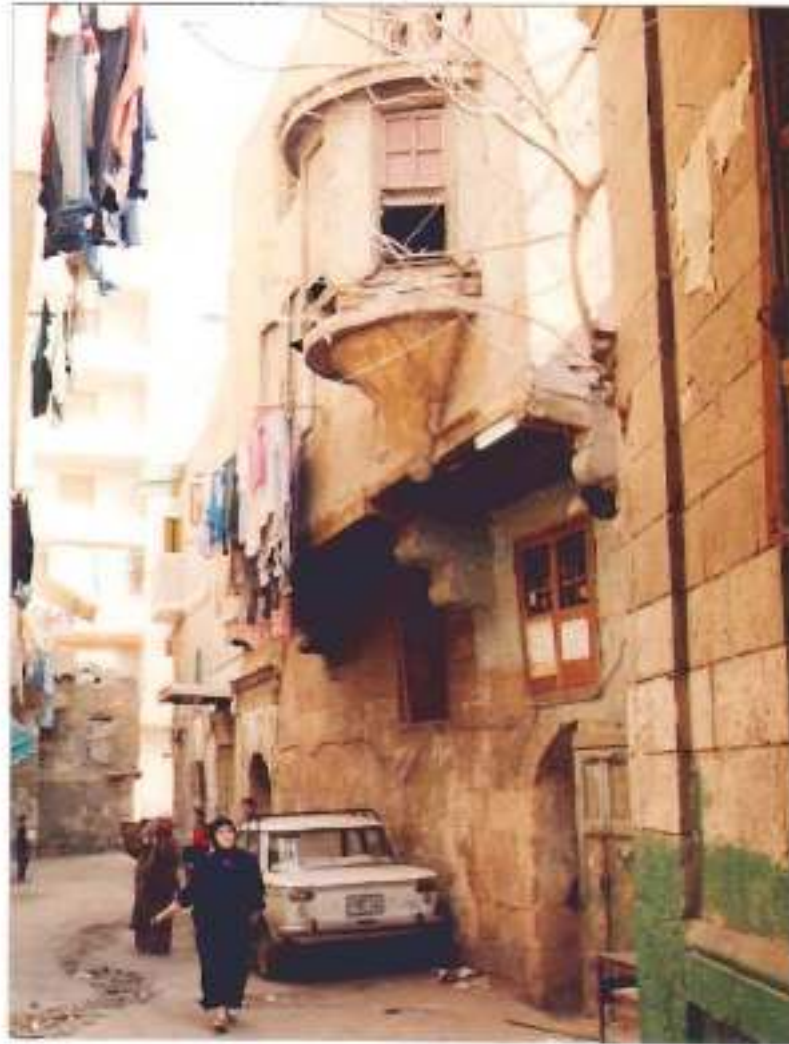
شكل رقم (١٥٠) يوضح الشباك الدائري الذي يحتاج إلى ترميم بواجهته بيت القزازين .
