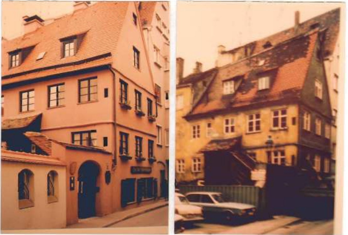
شكل رقم (٤٣) يوضح مثال مبنى سكنى بمدينة أوجسبورج قبل الترميم وبعد الترميم وتحسين المنطقة المحيطة .
