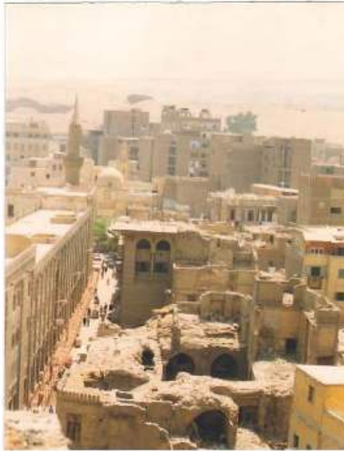
شكل رقم ( ١٢ ) يوضح منطقة الدراسة حيث شارع الشيخ محمد عبده ووكالة الدندللى والجامع الأزهر وسبيل وكتاب ووكالة قايتباى وجامع العينى .
