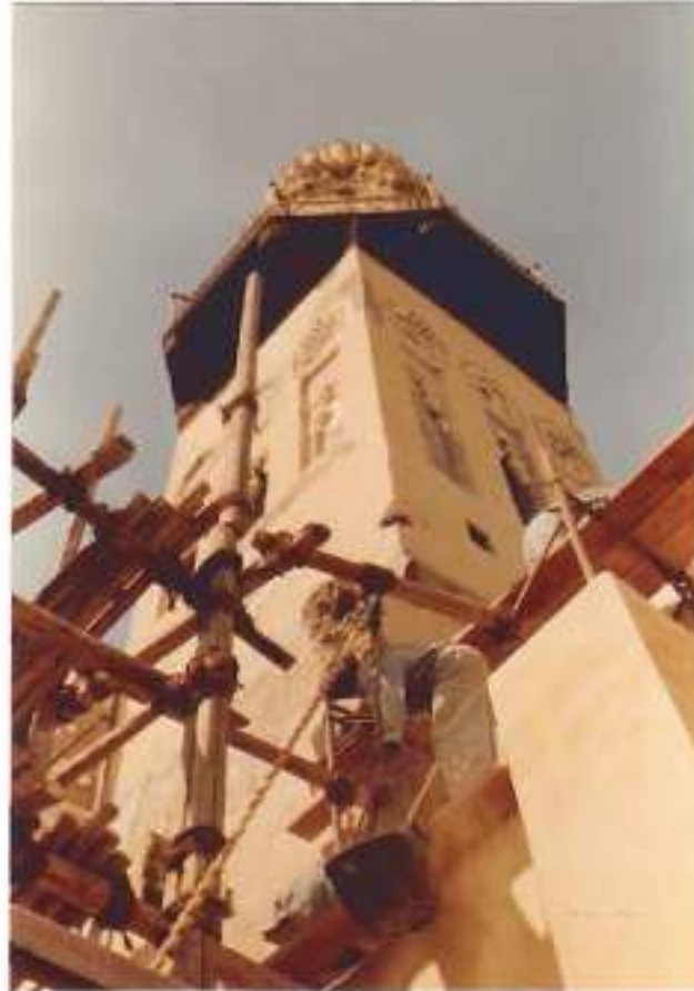
شكل رقم (٩١) يوضح مئذنة الصالح نجم الدين أيوب من جهة شارع المعز أثناء الترميم (١) .
