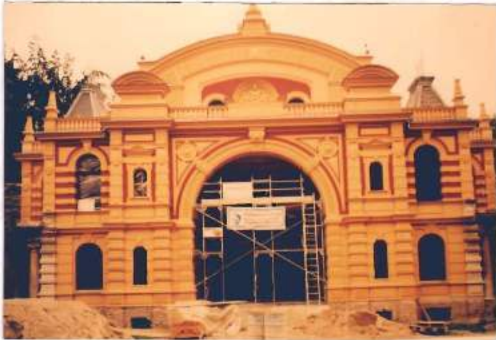
شكل رقم (٤٤) مسرح الكورنيش القديم أثناء عملية الترميم بأوجسبورج .
