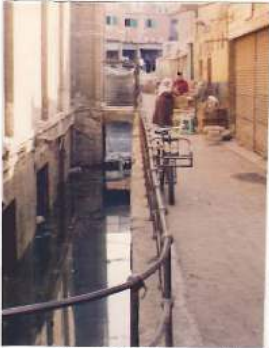
ارتفاع منسوب المياه الجوفية بدور المخللات بمسجد الصالح طلائع (شارع أحمد ماهر)
