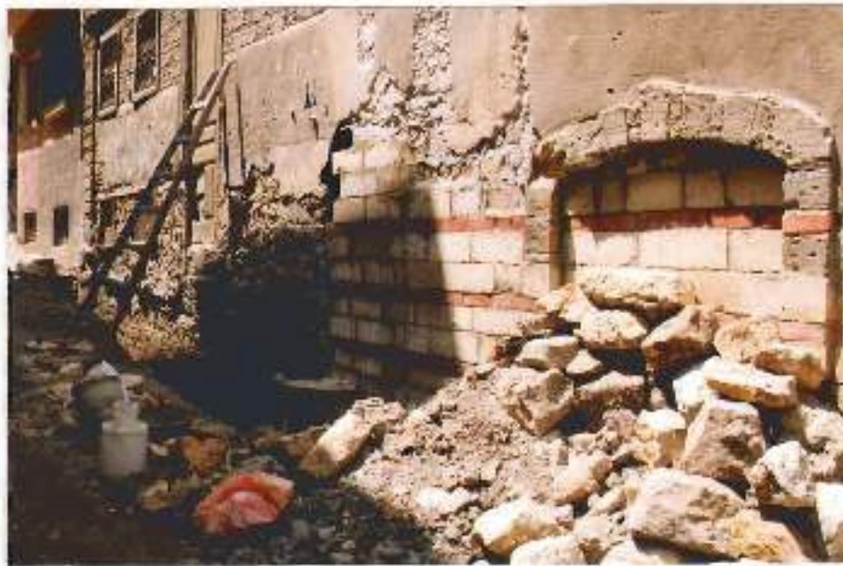
شكل رقم (٢٦) يوضح الواجهة الشمالية لبيت مسكر قبل وأثناء تغيير الأحجار التالفة.
