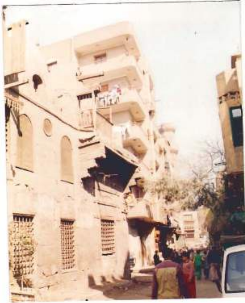
شكل رقم (١٤٤) يوضح عدم اندماج الجديد مع القديم بمنطقة شارع باب الوزير ، فظهرت مباني ذات ارتفاعات كبيرة حجبت رؤية المباني الأثرية .
