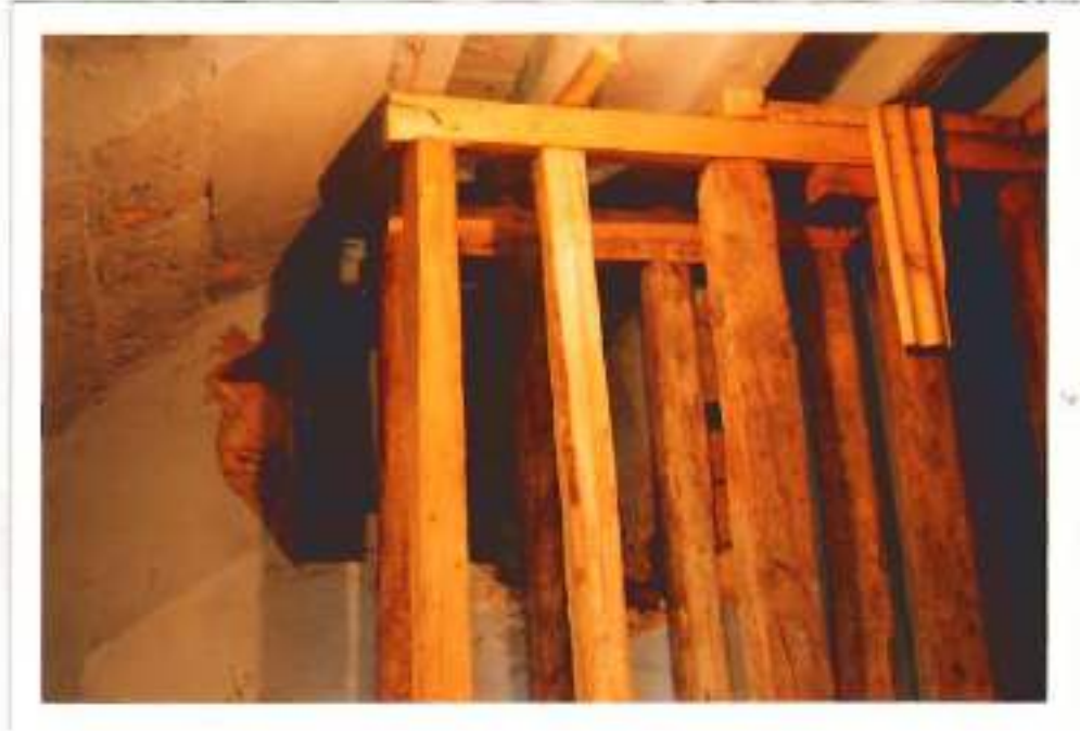
شكل رقم (٢٤) يوضح إصلاحات الأسقف الخشبية لبيت سكر .
