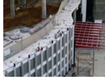
شكل رقم ( ٤ - ٩ ) التغليف الخارجي من الزجاج العاكس والالمنيوم والحديد المقاوم للصدأ والمقاطع الانبوبية العمودية (١) .
