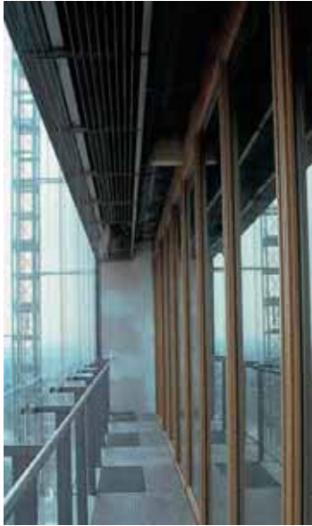
شكل رقم ( ٤ - ١٦ ) يوضح الواجهة المزدوجة لمبنى بوابة المدينة .
