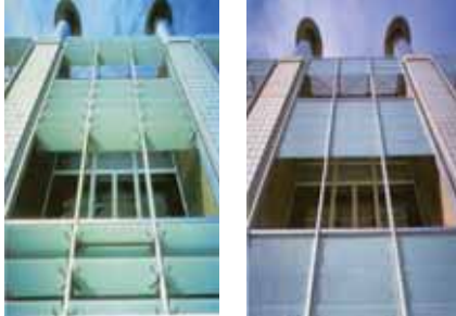
شكل رقم (٤-٢٦) يوضح الشرائح الزجاجية الدوارة الموجودة على الواجهة و أمكانية توجيهها حسب وضع الشمس (٤) .
