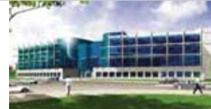
الواجهة الأمامية لمبنى شركة فودافون واستخدام مسطحات كبيرة من الزجاج العاكس والألمونيوم .
