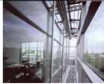
شكل رقم (٧٠-٢) لقطة داخلية توضح الفراغ الهوائي (Air Space) المتعدد الطوابق في مبنى فيكتوريا بألمانيا
