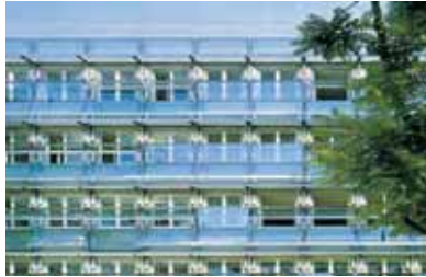
شكل رقم (٤- ٣٧) يوضح الواجهة الجنوبية الشرقية و الجنوبية الغربية لمبنى شركة سופا و التي يتضح بها استخدام النوافذ المتحكم بها عن طريق الكمبيوتر للتحكم في الإضاءة الطبيعية.
