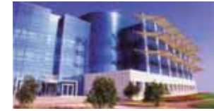
تغطية مساحات كبيرة من واجهة المبنى بالحوائط الستائرية المصنوعة من أطارات من الألمونيوم و الزجاج العاكس المعالج حراريا (tempered glass).
