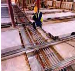
شكل رقم ( ٢٩ - ٤ ) يوضح شبكة المواسير تحت الأرض (Under Floor Pipe Work) التي تعمل على تبريد بلاطة الأرضية باستخدام المياه الجوفية .
