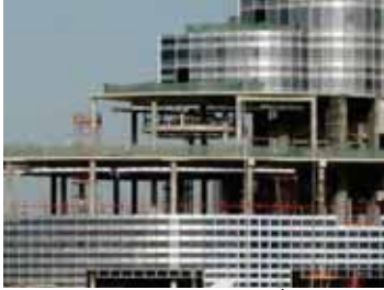
شكل رقم ( ٤ - ٩ ) التغليف الخارجي من الزجاج العاكس والالمنيوم والحديد المقاوم للصدأ والمقاطع الانبوبية العمودية (١) .
