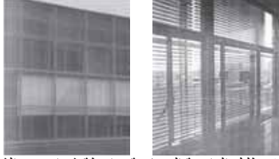
شكل رقم ( ٣٩-٤ ) تظليل الواجهة الزجاجية بواسطة شرائح من الشيش المعدي القابل للانعكاس (Reversible Venetian Blinds) داخل التجويف للتحكم في نفاذ الإضاءة الطبيعية (٢).
