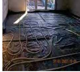
شكل رقم ( ٢٩ - ٤ ) يوضح شبكة المواسير تحت الأرض (Under Floor Pipe Work) التي تعمل على تبريد بلاطة الأرضية باستخدام المياه الجوفية .
