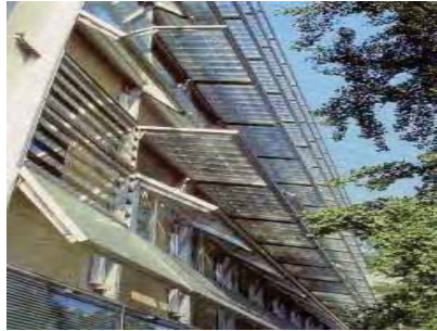
شكل رقم (٤ - ٣٦) يوضح لقطة خارجية للغلاف الذكي الجديد ويتضح بها مجموعة الشبابيك الأفقية الثلاثة التي تساعد على تحسين الأداء الحراري للمبنى .
