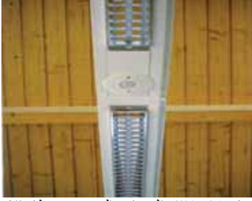
شكل رقم ( ٢٧ - ٤ ) الحساس المستخدم بنظام الإضاءة لقياس مستويات الإضاءة الطبيعية ومستوى الأشغال و مزود بجهاز استقبال بالأشعة تحت الحمراء (١) .
