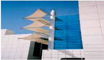
شكل رقم (٤ - ٤) يوضح معالجة الحوائط الستائرية بوضع مظلات نسيجية من مادة "التفلون" كوسيلة تظليل أفقية ثابتة
