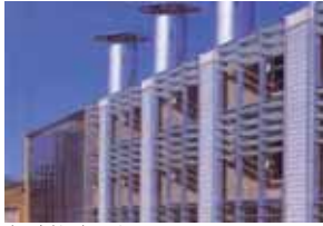
شكل رقم (٤-٢٥) يوضح نظام التظليل الخارجي المستخدم بالمبنى للتحكم في مستويات الإضاءة الطبيعية (١)
