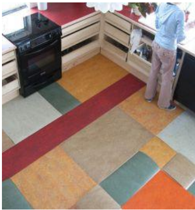
شكل رقم ( ٣٧ ) يوضح بعض أنواع الأرضيات اللينوليوم
