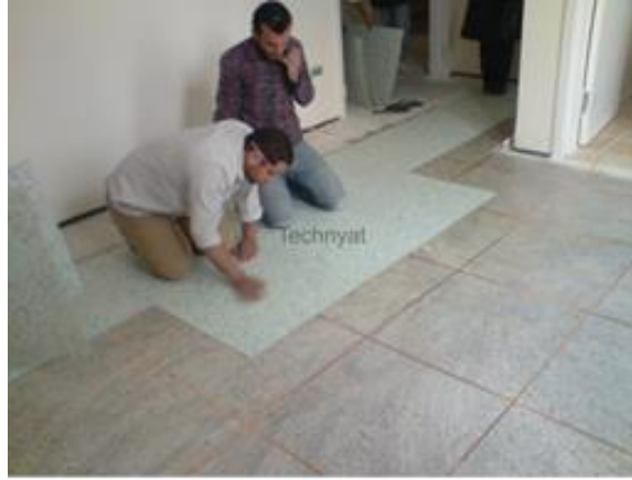
شكل رقم ( ٣٨ ) يوضح تركيب الفينيل فوق الشبكة المعدنية
