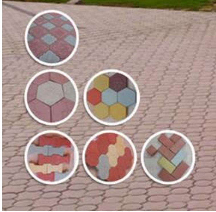
شكل رقم ( ٤٢ ) يوضح بعض الأرضيات الانترلوك
