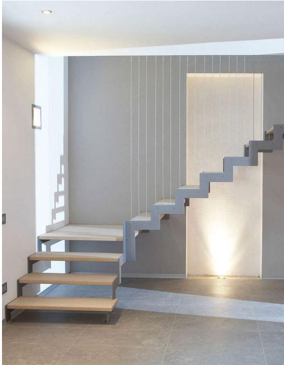
شكل رقم ( ٢٧ ) يوضح درج ربع دورة
