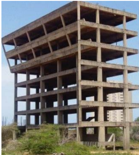
شكل (9): قطاع رأسي لمبنى منشأ بطريقة الإنشاء الهيكلية
