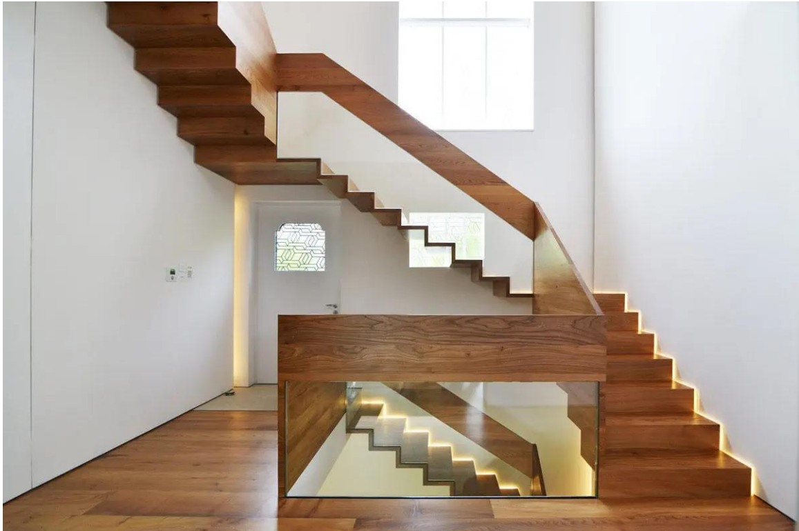
شكل رقم ( ٢٨ ) يوضح درج نصف دورة
