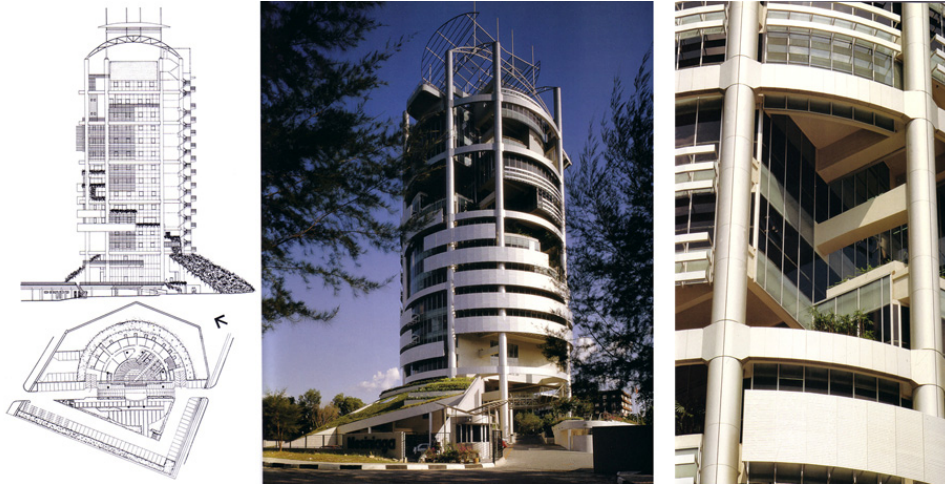
شكل (٩): مشروع Menara Mesiniaga، ماليزيا، يوضح إمكانية توظيف كاسرات أشعة الشمس في مبنى عالي التقنية لتوفير قدر من الحماية من أشعة الشمس المباشرة بالإضافة إلى دور تشكيل كتلة المبنى [٢٥] .
