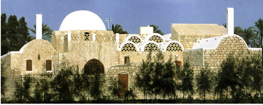
شكل (٦): مبنى من أعمال حسن فتحي يوضح إستعمال الأحجار الطبيعية في البناء بالإضافة لتأثير لونها الفاتح وطلاء بعض أجزاء سطح المبنى باللون الأبيض [١٩] .
