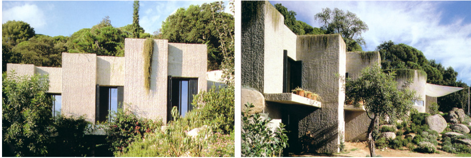
شكل (١١): نموذج مبنى سكني يوضح إمكانية استخدام النباتات في التظليل إلى جانب تشكيل كتلة المبنى [٢٦] .
