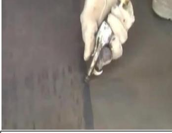
شكل (2) يوضح تنظيف سطح الخرسانة تماما من أجزاء الخرسانة الضعيفة أو المفككة أو زيد الأسمت. المصدر : 12
