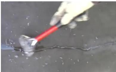
شكل (8) يتم حك سطح الخرسانة بعد أن تجف المادة و تتماسك مع الخرسانة و تصبح كأنها جزء منها ، ثم بتنظيف السطح و مساواته تماما. المصدر: 12
